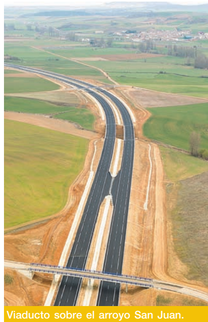
Viaducto sobre el arroyo San Juan.
