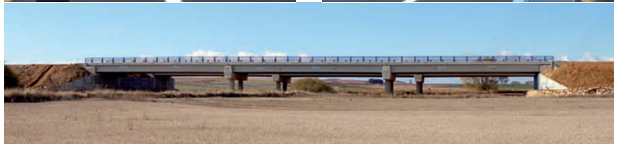
Fotos superiores: Vista parcial del tramo abierto al tráfico. Foto inferior: Viaducto sobre el Vallarna.
