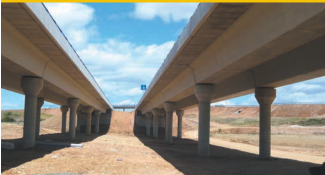
Viaducto sobre el río Burejo.
