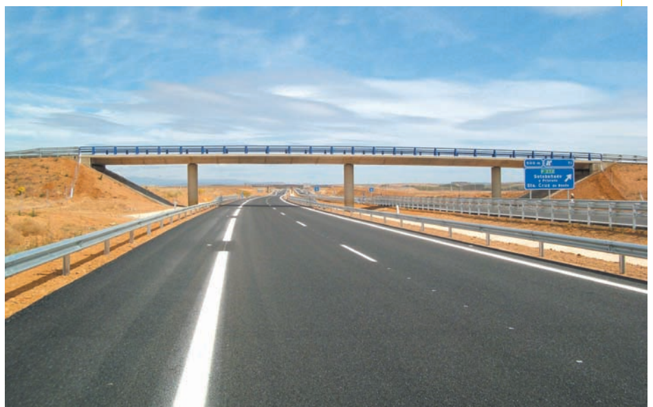
Vista del tramo finalizado en el p.k. 2+400.
