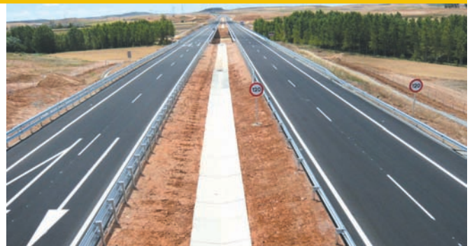
Vista del tramo en el p.k. 1+000.
