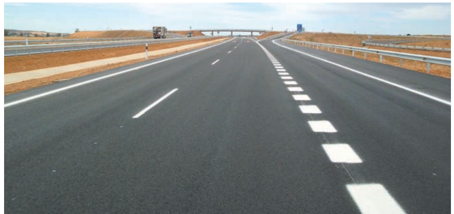
A lo largo del tramo se han dispuesto un enlace en cuyas proximidades está tomada la foto, 7 pasos superiores y 2 inferiores.
