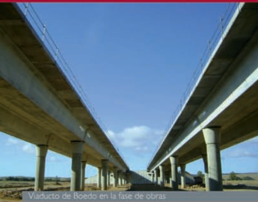
Viaducto de Boedo en la fase de obras
