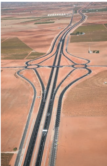
Vista panorámica del enlace con la CM-3111.
