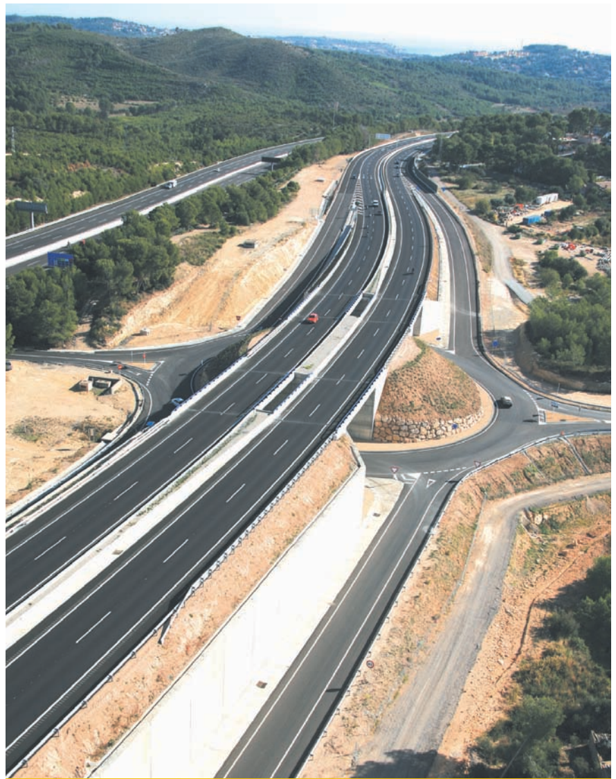
Enlace en el p.k. 5+500 con la carretera del Catllar.
