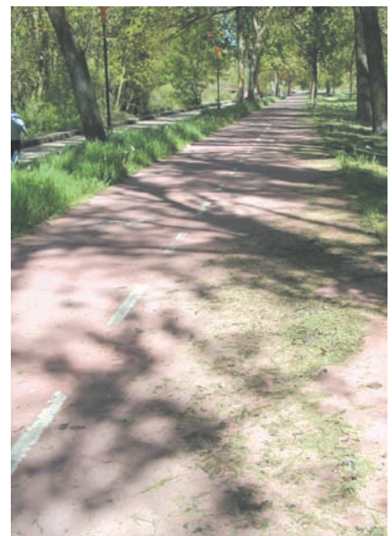
Foto 13. Limpieza y mantenimiento
