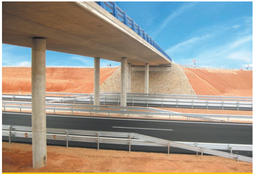
A lo largo del tramo, se han proyectado 5 pasos superiores, formados por una losa continua: 4 de ellos de 3 vanos, y el de la imagen superior de 4; todos ellos de hormigón pretensado, con sección transversal en ala de gaviota, y estribos de hormigón armado.
