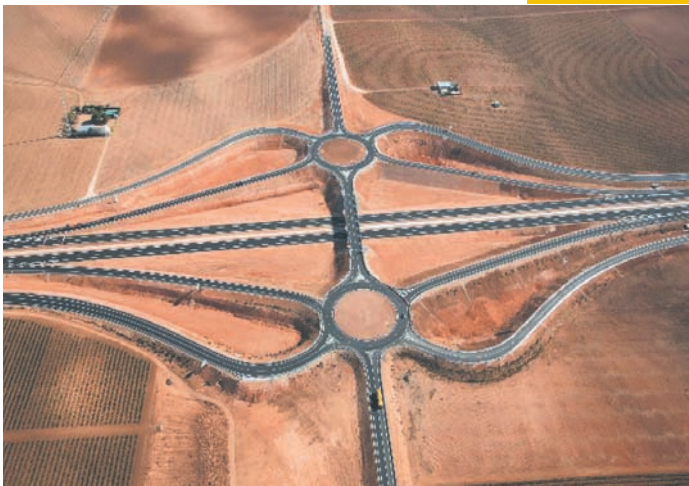
Enlace con la CM-3111, de tipo diamante completo con pesas, que conecta la autovía con los municipios de Socuéllamos y Sotuelamos.
