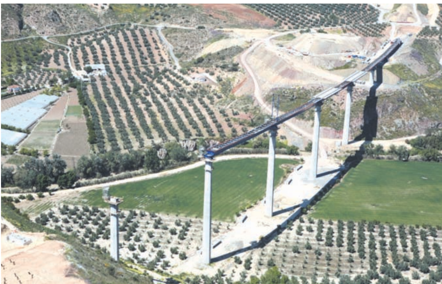
Viaducto sobre el río Genil en fase de construcción.
