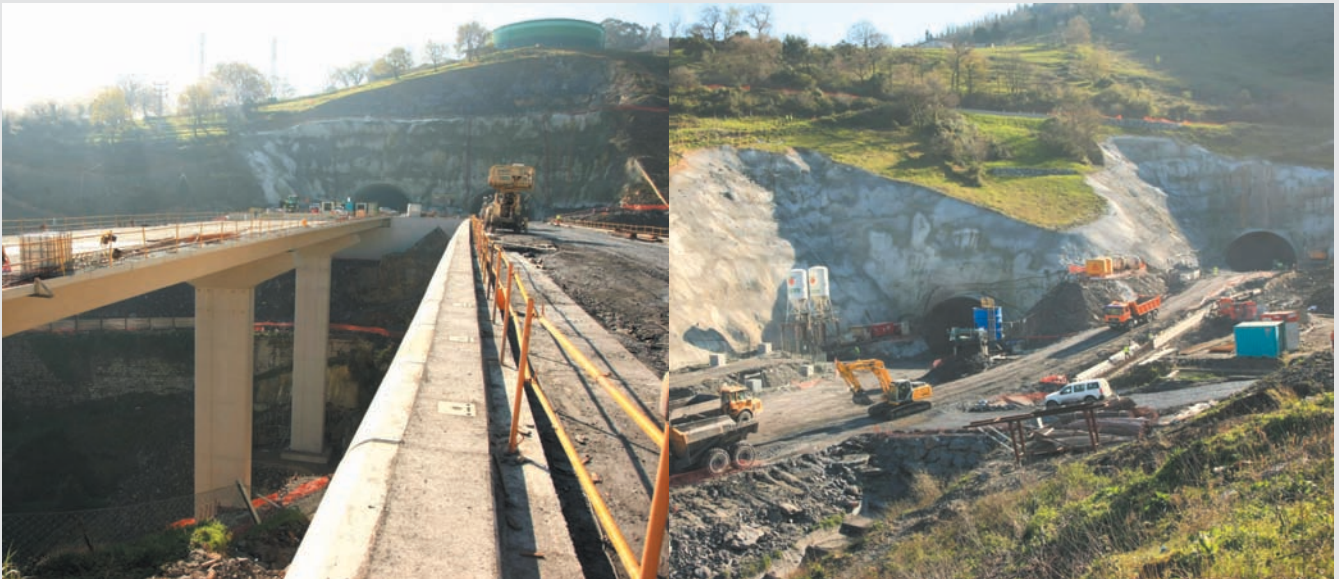
Vistas panorámicas de la Variante Sur Metropolitana en fase de construcción.
