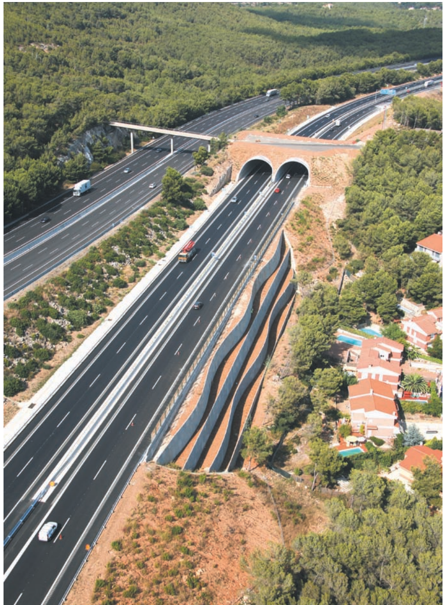
Muro de tierra armada y falso túnel.
