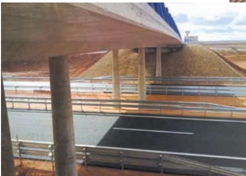
Los pasos superiores están constituidos por una losa continua de hormigón pretensado de sección trapezoidal con voladizos en ambos lados.
