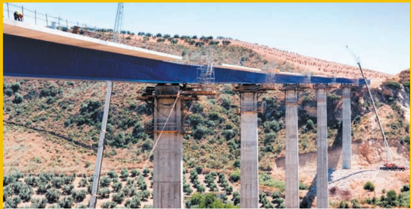
Fases lanzamiento Viaducto E-3
