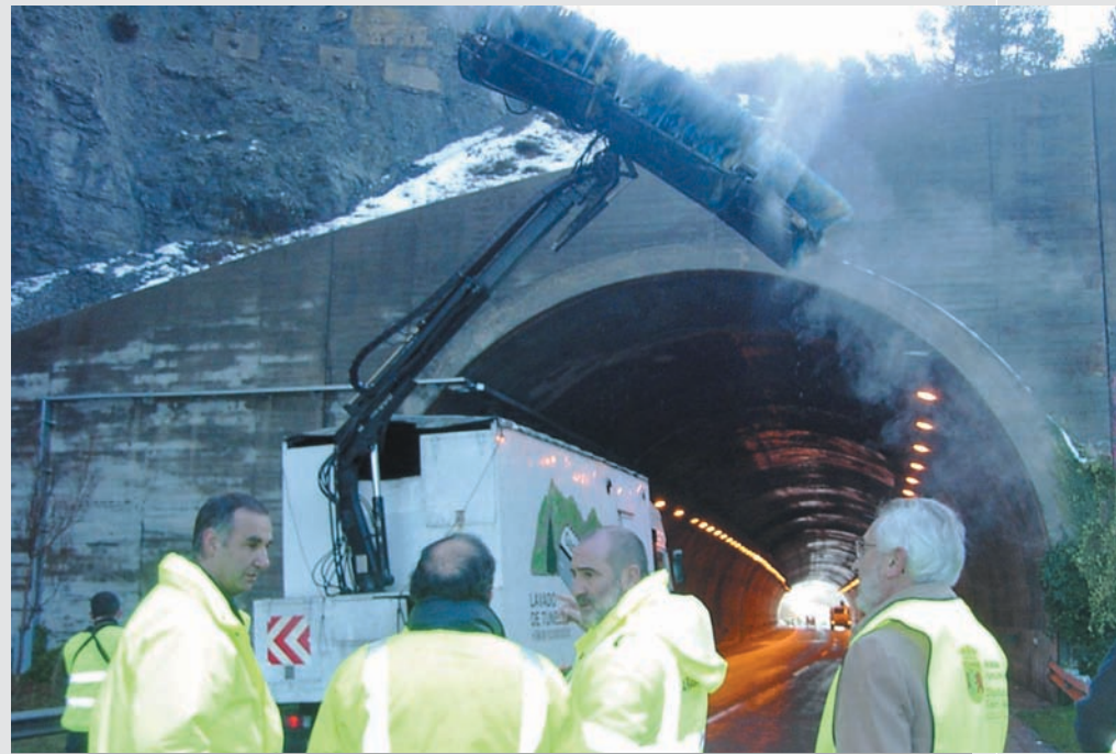
El Sr. Zarrabeitia durante una visita al túnel de Airdin (Autovía de Altube, que lleva a Bilbao) cuando se realizaron labores de limpieza.
