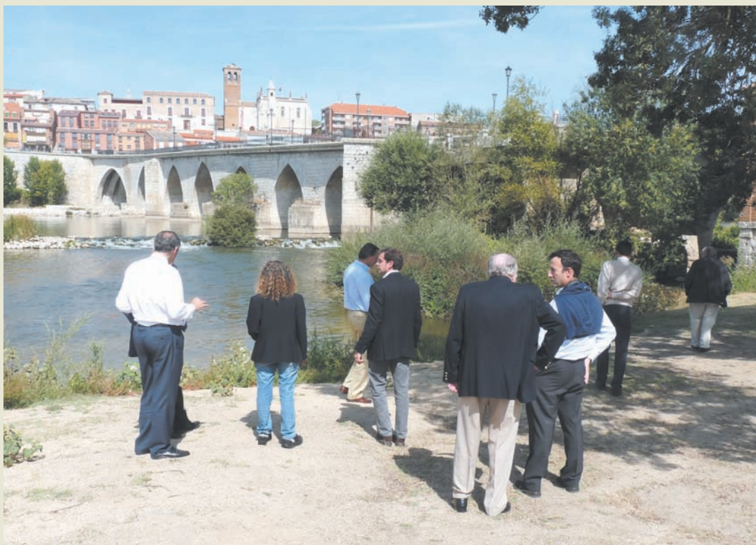
Visita al puente de Tordesillas que será rehabilitado próximamente.
