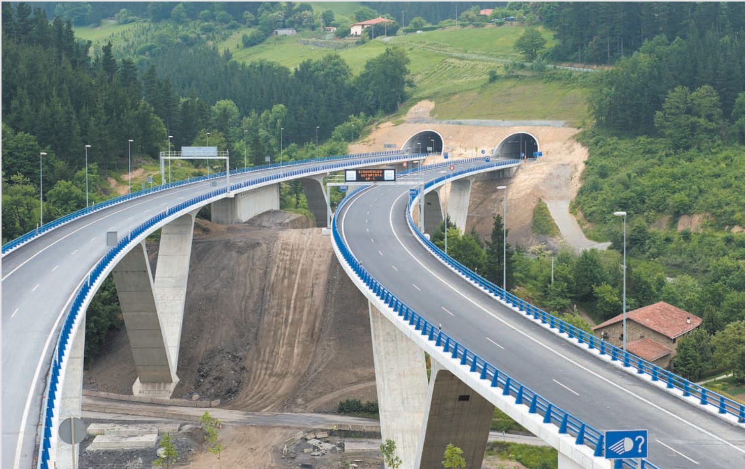
La apertura, el pasado mes de mayo, de la Autopista Eibar-Vitoria ha culminado la obra pública más ambiciosa de Gipuzkoa.
