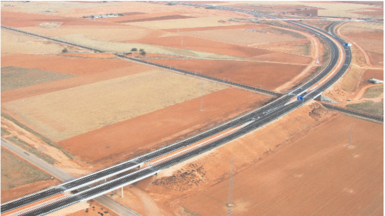
A lo largo del trazado se han diseñado un total de 8 pasos superiores, 3 inferiores y 1 muro. En la foto se aprecia el paso superior sobre la línea de ferrocarril Madrid-Cádiz.
