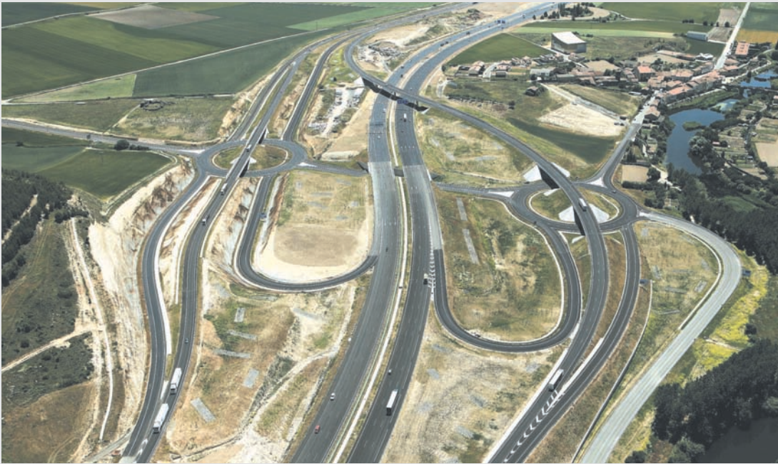
Superenlace de la N-1 con las europistas en Armiñón.
