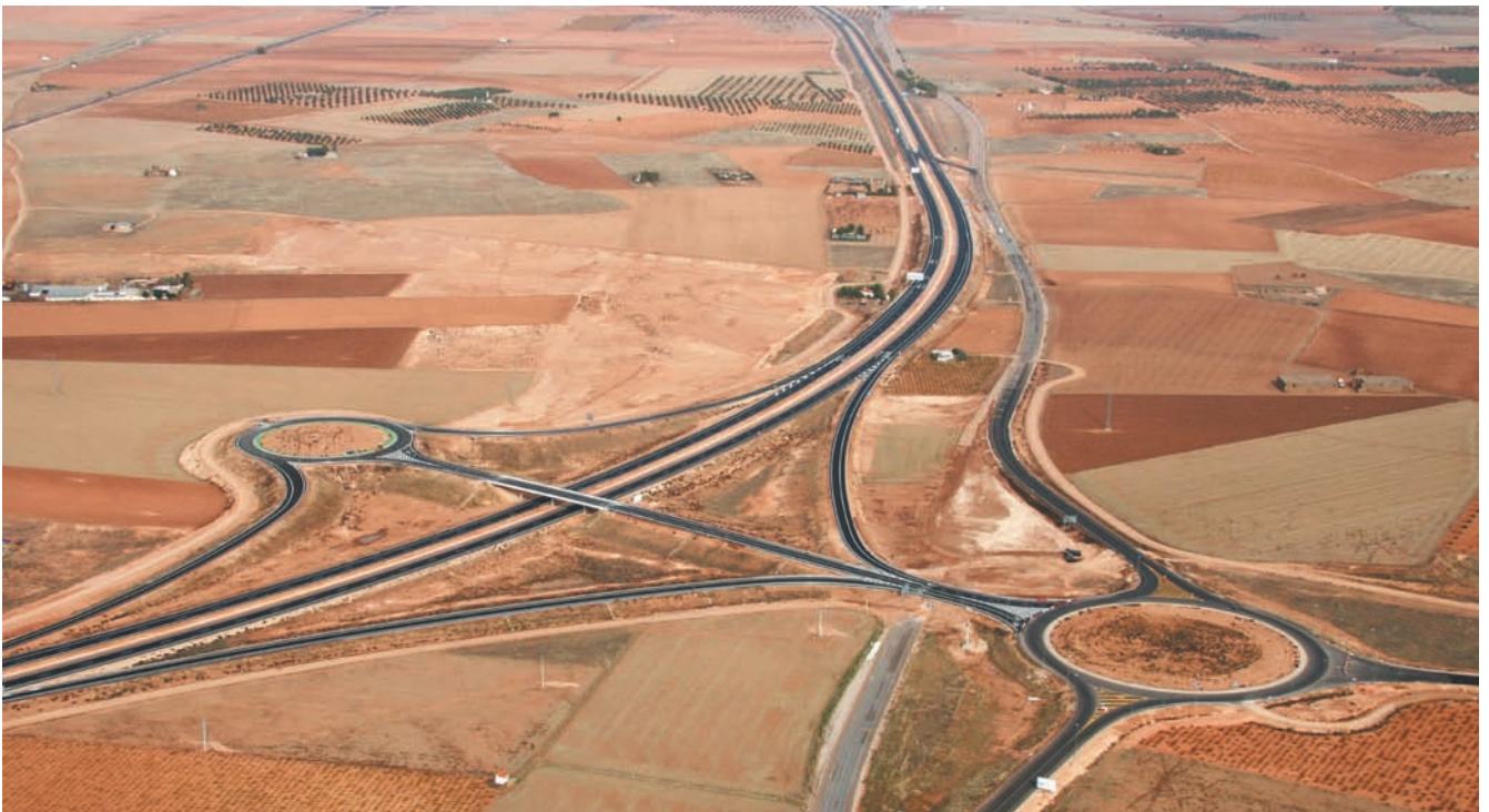
Se han construido 2 enlaces. El enlace nº 1, de tipo pesa, conecta la A-43 con el ramal a Membrilla, siendo el enlace nº 2 el que conecta este ramal con la actual N-430.
