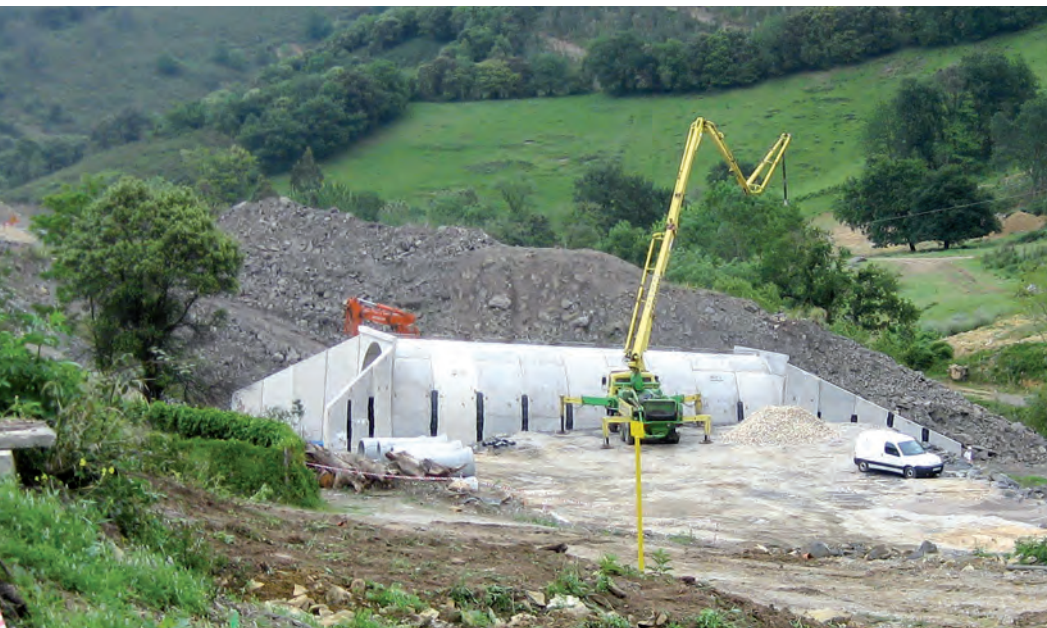
Paso interior mediante estructura prefabricada
