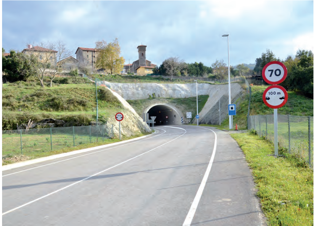
Entrada al túnel de Santullán
