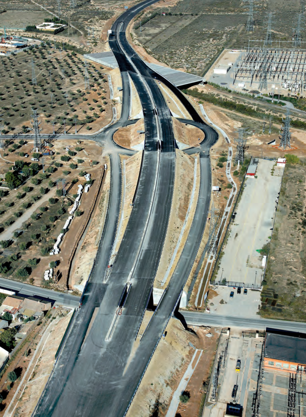
Vista del enlace Norte y del paso sobre la carretera autonómica RM-603 en fase de ejecución
