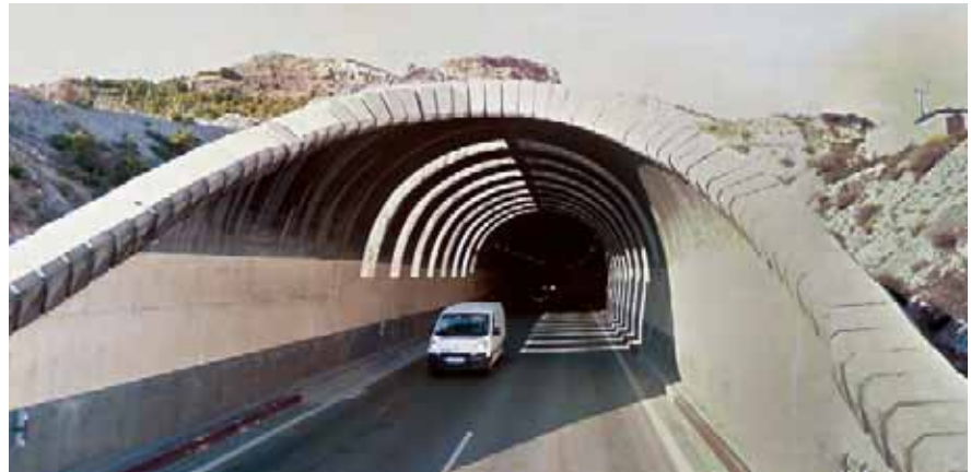
Figura 7: Túnel de Lorca (Murcia).
