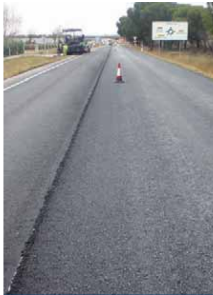
Mezcla Templada con Emulsión Bituminosa.
