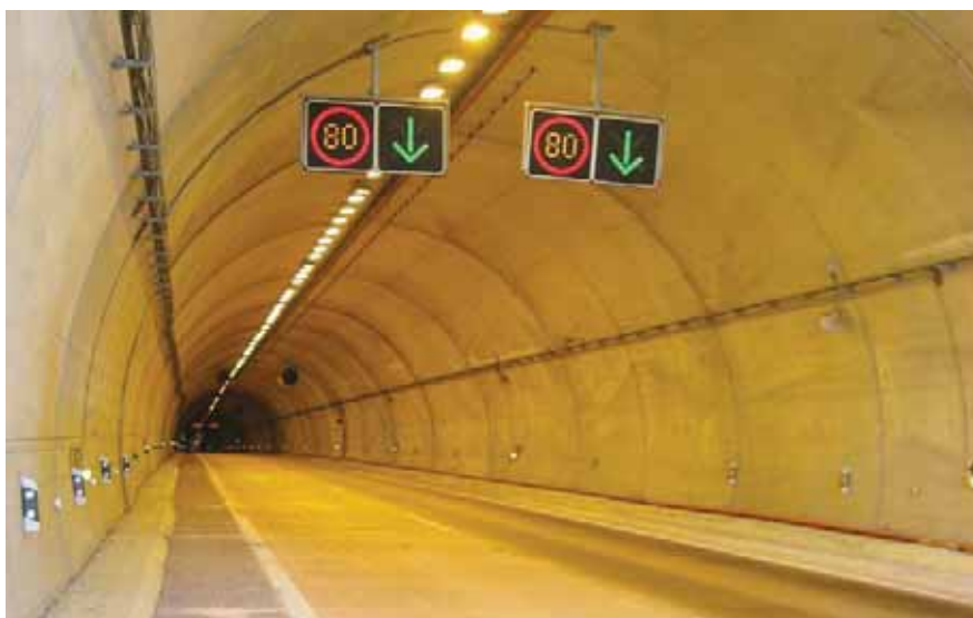
Figura 2: Iluminación de túnel con proyectores instalados en disposición cenital. *Imagen correspondiente al interior del túnel Loma de Bas de la Autopista AP-7 (tramo Cartagena - Vera).
