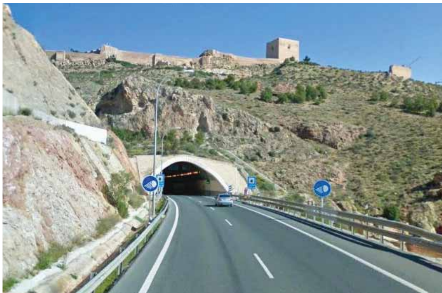
Figura 1: Efecto “agujero negro” a la entrada de un túnel, paliado mediante proyectores. *Imagen correspondiente al acceso sur del túnel de la variante de Lorca en Murcia.
