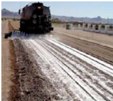
ESTABILIZACIÓN DE SUELOS
