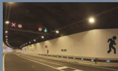
Túnel del Pont Pla.
