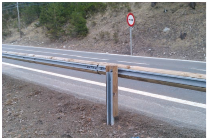
Figura 11. Vista posterior de la barrera de seguridad en el Km.17 de la carretera M-604.
