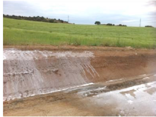
TRATAMIENTOS ANTIEROSIÓN DE TALUDES
