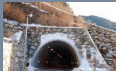
Dique de Arinsal.
