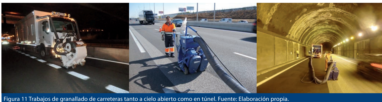
Figura 11 Trabajos de granallado de carreteras tanto a cielo abierto como en túnel. Fuente: Elaboración propia.
