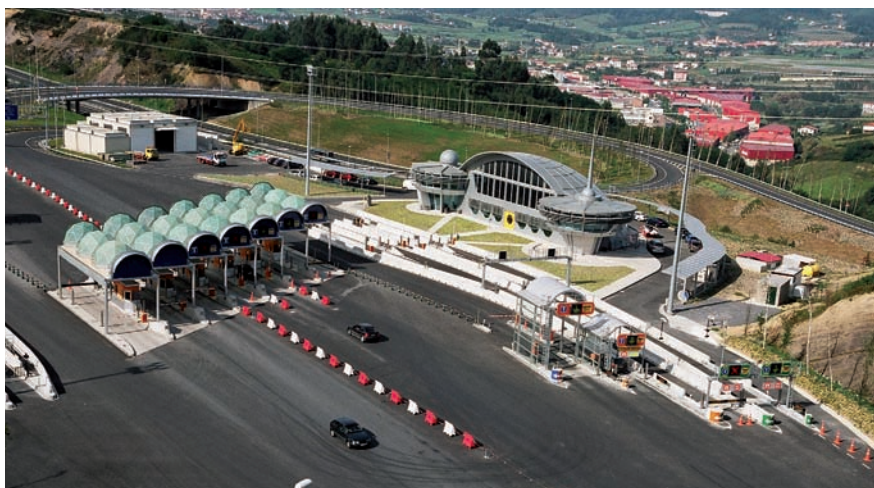
Figura 12. Túneles de Artxanda. Peaje.
