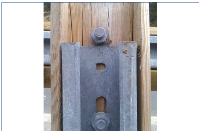
Figura 12. Detalle de acoplamiento al poste.
