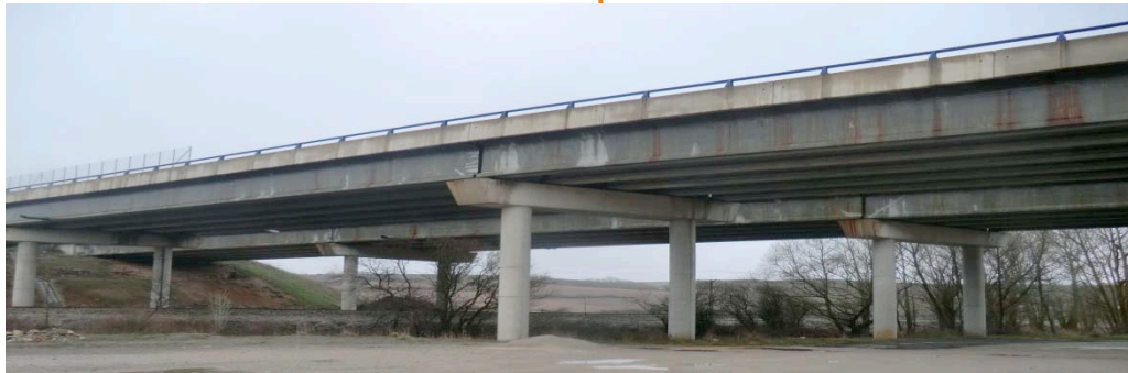
REPARACIÓN DE ESTRUCTURAS
