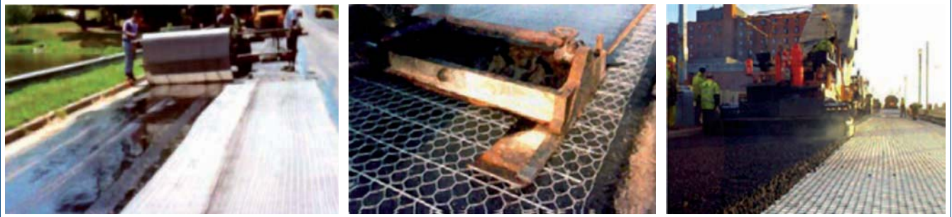
Figura 1. Ejemplos de aplicación en obra de geotextil impregnado, malla metálica y geomalla.
