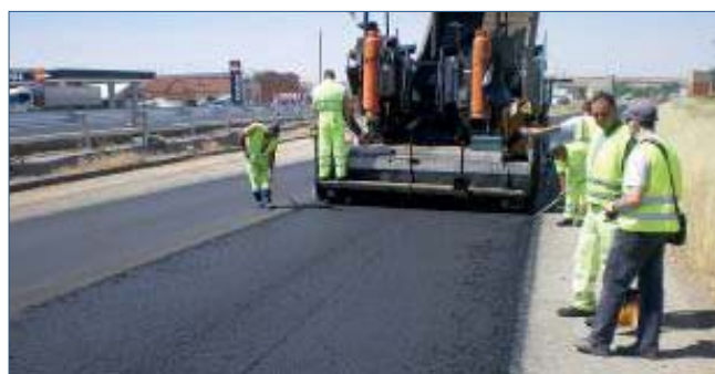
Figura 9. Extendido de la mezcla templada reciclada en la experiencia realizada en la A-1 en el año 2012
