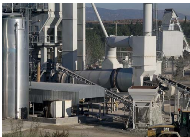
Figura 4 - Incorporación del fresado en el conducto de descarga del tambor secador
