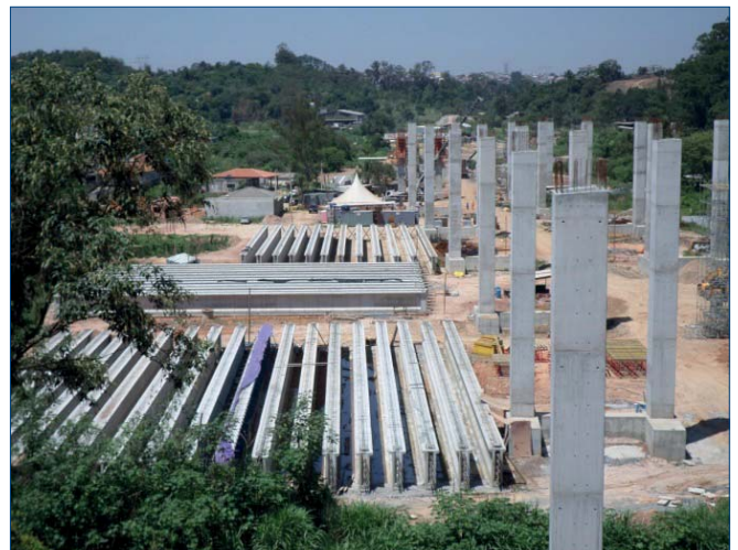
Foto 19. Vista de patios de vigas junto al alzado del viaducto OAE.469
