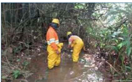
Fotos 9 y 10. Limpieza de ramas y succión de lodos, en proximidades a viviendas para evitar inundaciones
