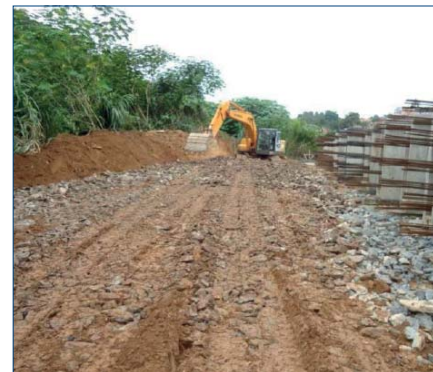
Foto 14. Mejora del terreno con piedra triturada procedente del túnel, por falta de consistencia del terreno natural en las áreas de prefabricación
