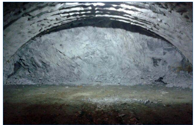
Foto 27. Excavación en Metasitos
