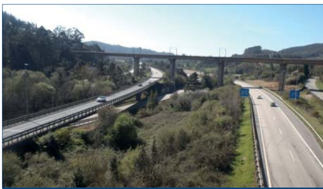
Figura 5. Imagen desde una estructura del pavimento de hormigón
