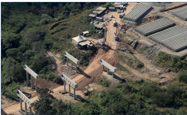
Foto 20. Vista de patios de vigas próximo a estribo del puente OAE.406
