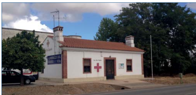
Figura 3. Estado actual de casilla de peón caminero
