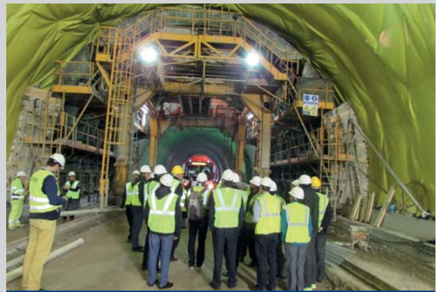
Visita túnel Caldearenas. Carro de encofrado del revestimiento
