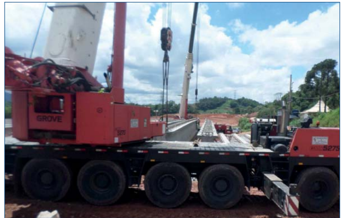
Foto 17. Control de manipulación de vigas, antes del lanzamiento definitivo
