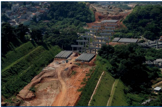
Foto 4. Vista aérea del trazado a media ladera con 32 m de talud (lado izquierdo) + 24 m (lado derecho)
