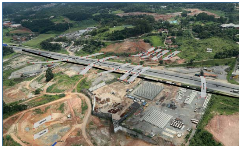
Foto 6: Montaje sobre foto aérea de la implantación de los puentes que cruzan la autovía Fernão Dias.
