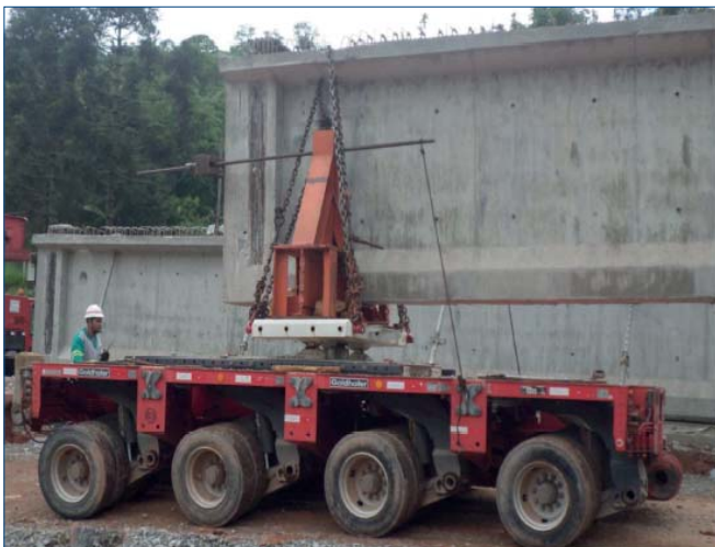
Foto 18: Transporte de las vigas en patios construidos a pie de estribo
