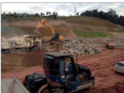
Foto 28. Planta de machaqueo dentro de la traza
