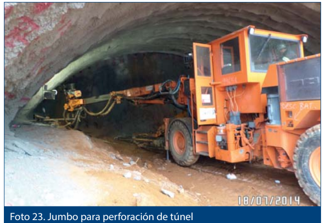
Foto 23. Jumbo para perforación de túnel
