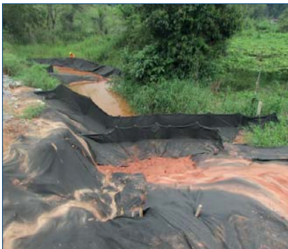
Fotos 35, 36 y 37. Barreras de geotextil para contención de finos
