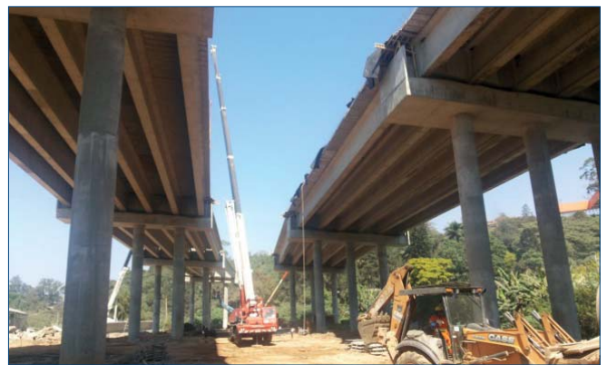
Foto 21. Lanzamiento de vigas doble T, de 40 m
