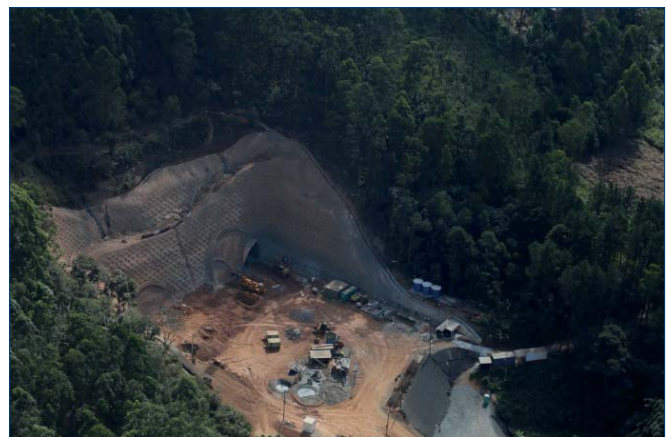
Foto 5. Vista aérea emboquille Leste. Túnel 401
