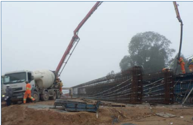
Foto 16. Hormigonado de las vigas, con las vainas de tesado colocadas para posterior tesado
