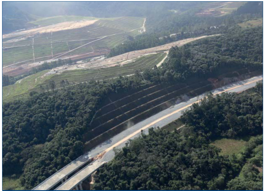
Foto 38. Talud en desmonte (a izquierda e traza) de 40 m de altura
