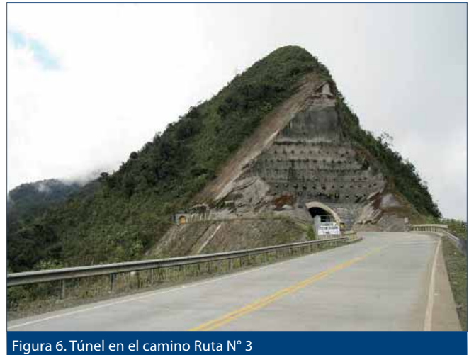
Figura 6. Túnel en el camino Ruta N° 3
