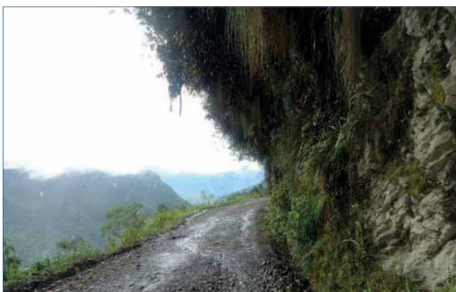
Figura 13. Imágenes de la calzada del antiguo camino a Coroico
