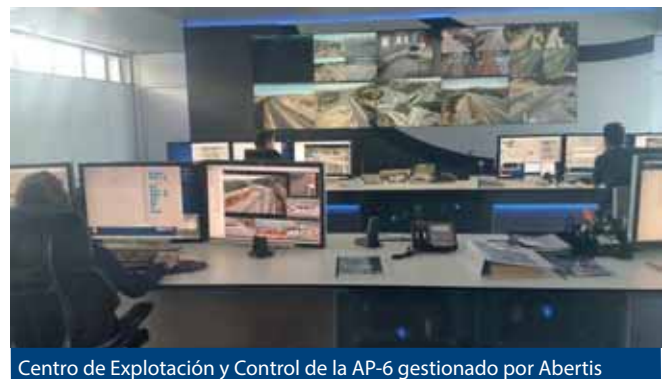
Centro de Explotación y Control de la AP-6 gestionado por Abertis
