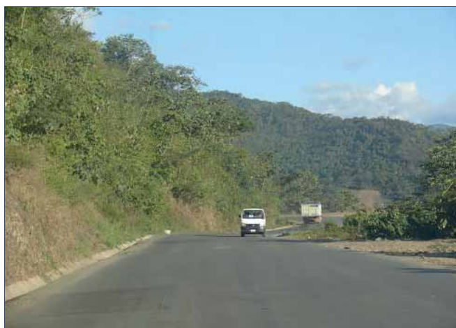
Figura 14. Carretera Nacional N° 3 Santa Bárbara – Caranavi
