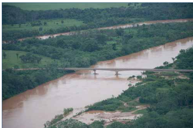
Figura 24. Ruta N° 3 Puente sobre el río Maniqui
