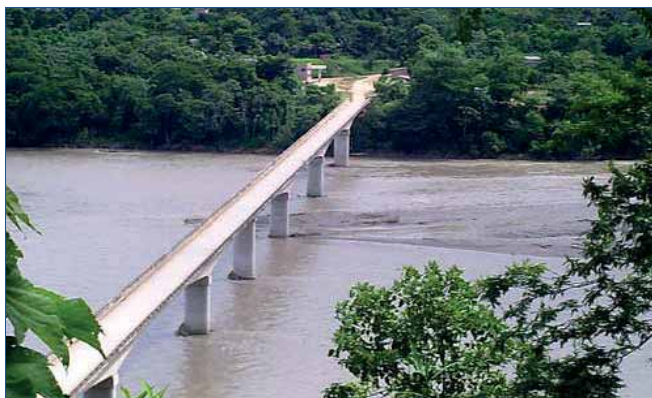
Figura 18. Puente sobre el Río Alto Beni
