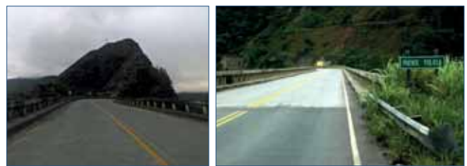
Figura 7. Infraestructura de puentes en la Ruta N° 3
