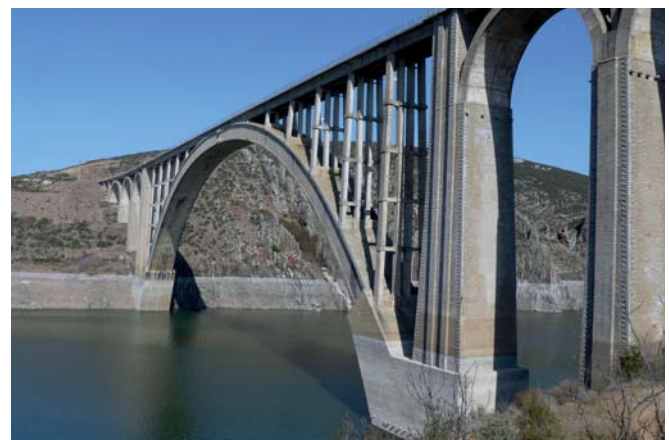
Figura 3. Viaducto Martín Gil (1934-1942)
