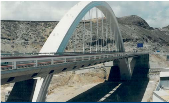
Figura 8. Viaducto de Tamaraceite (1995)
