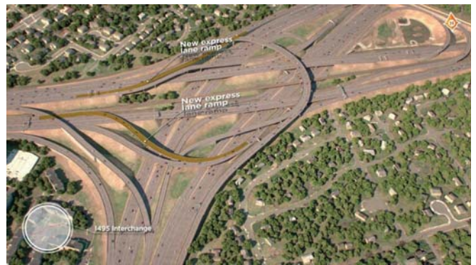
Figura 16. Autopista I66 OTB Virginia (2017-2018)
