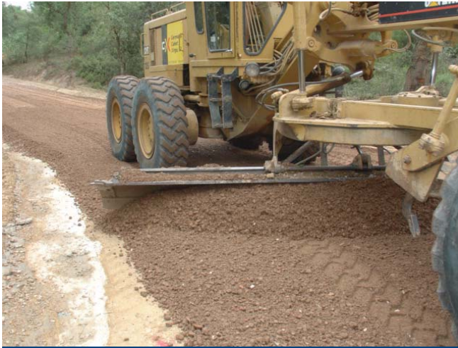
Foto 3. Construcción de un firme de carretera con árido procedente de residuos de construcción y demolición (Imagen facilitada por la Asociación Española de Reciclaje de Residuos de Construcción y Demolición)
