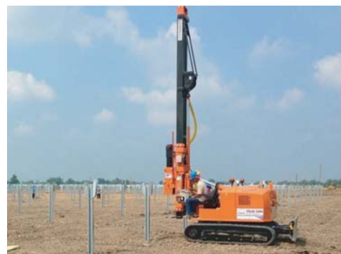
Máquina hinca postes Pauselli trabajando en planta termosolar.
