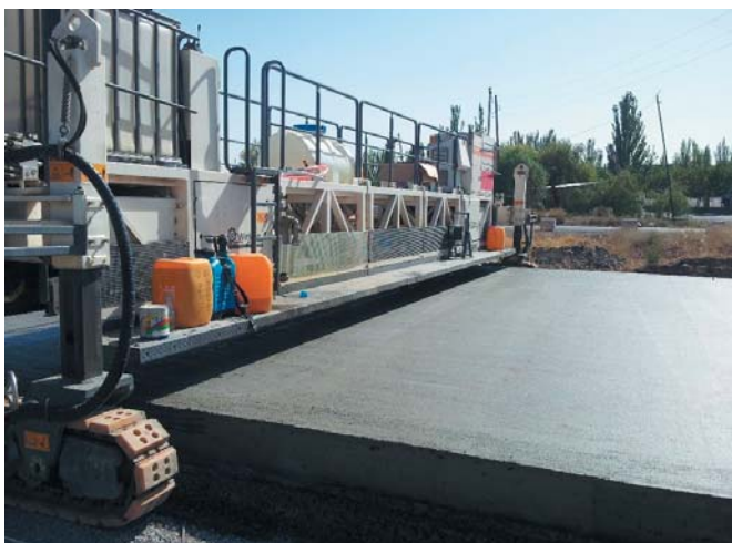
Extendidora de hormigón con insertadores (DBI) y carro de curado de Lantania
