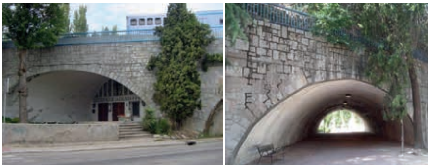
Figura 11. Puente de Arroyo-fresno
