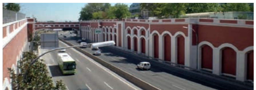
Figura 10. Vista general fin de obra del Puente de la Cea
