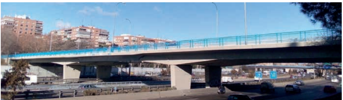
Figura 15. Vista general fin de obra del Puente de la Paz
