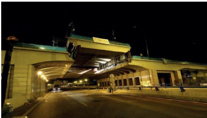
Figura 13. Vista general fin de obra del Puente de Avenida del Mediterráneo
