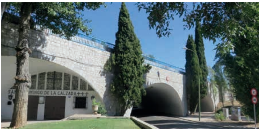
Figura 12. Vista general fin de obra del Puente de Arroyo-fresno
