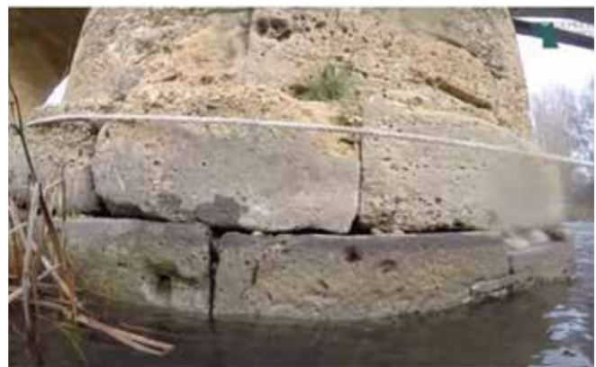
Figura 9. Juntas lavadas sobre la lámina de agua
