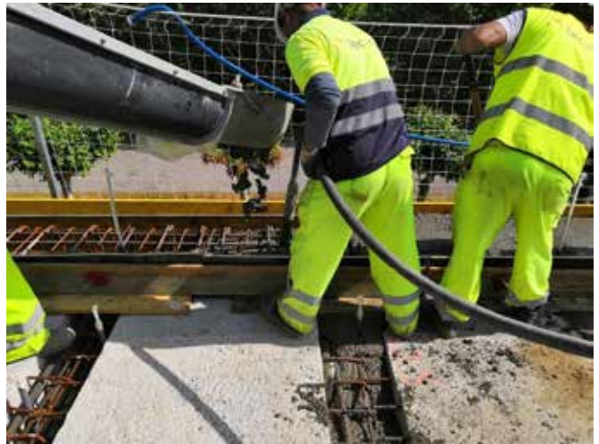
Figura 22. Hormigonado de juntas y pedestal de pretil
