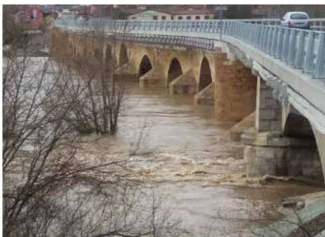
Figura 26. Vista durante la riada en diciembre 2019
