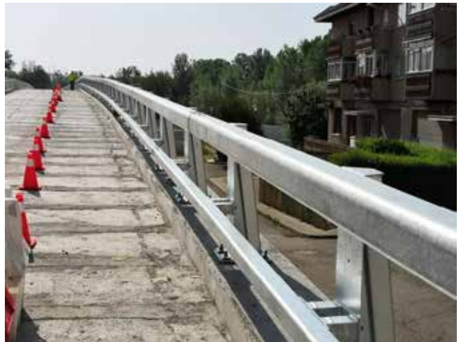
Figura 23. Pretil colocado.
