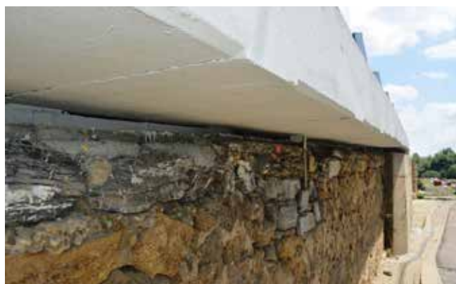
Figura 14. Apoyo de losas del ensanche en rampa sur (lado León)
