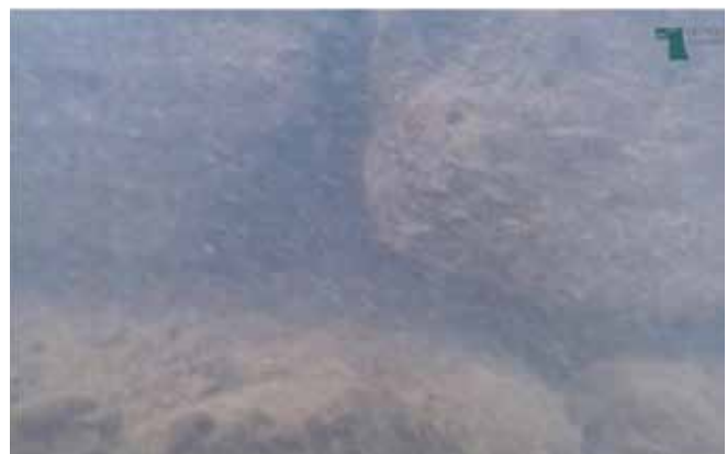
Figura 10. Juntas lavadas bajo la lámina de agua
