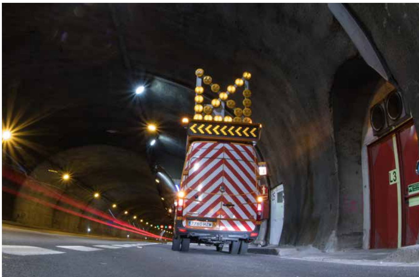
Trabajos de mantenimiento en túnel de Guadarrama
