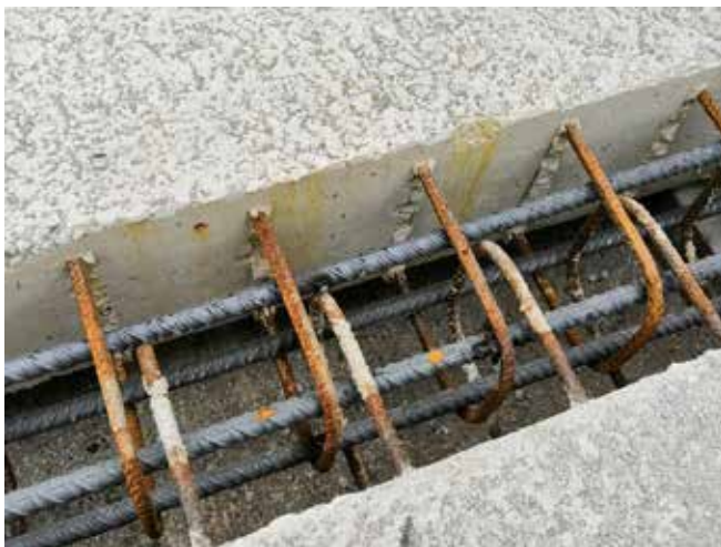
Figura 21. Juntas entre losas antes del hormigonado
