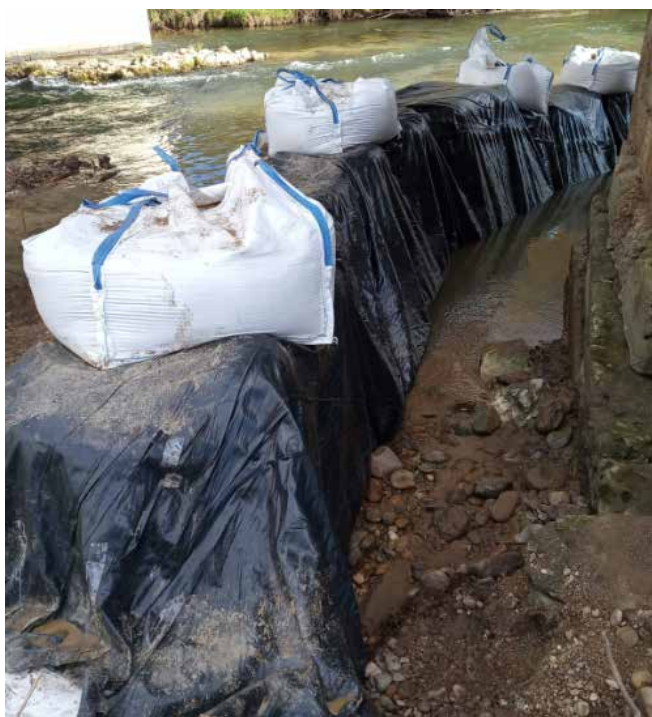
Figura 17. Ejecución de recinto estanco para actuar sobre la cimentación de pila 14
