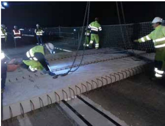
Figura 20. Colocación de prelosa
