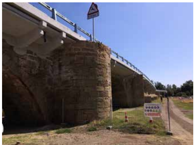
Figura 24. Vista parcial de la obra terminada
