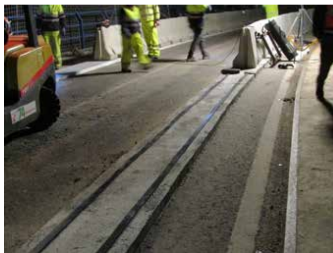
Figura 18. Faja de apoyo ejecutada
