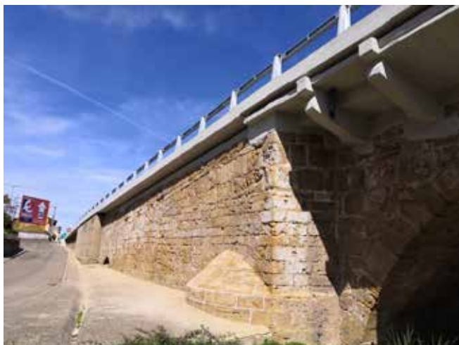
Figura 25. Aspecto parcial de la obra terminada
