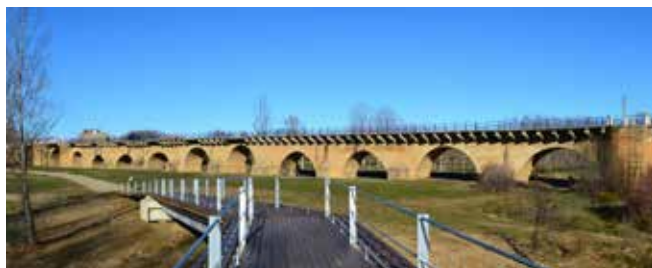
Figura 2. Situación del puente previa a la actuación
