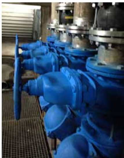
Bombas de drenaje
