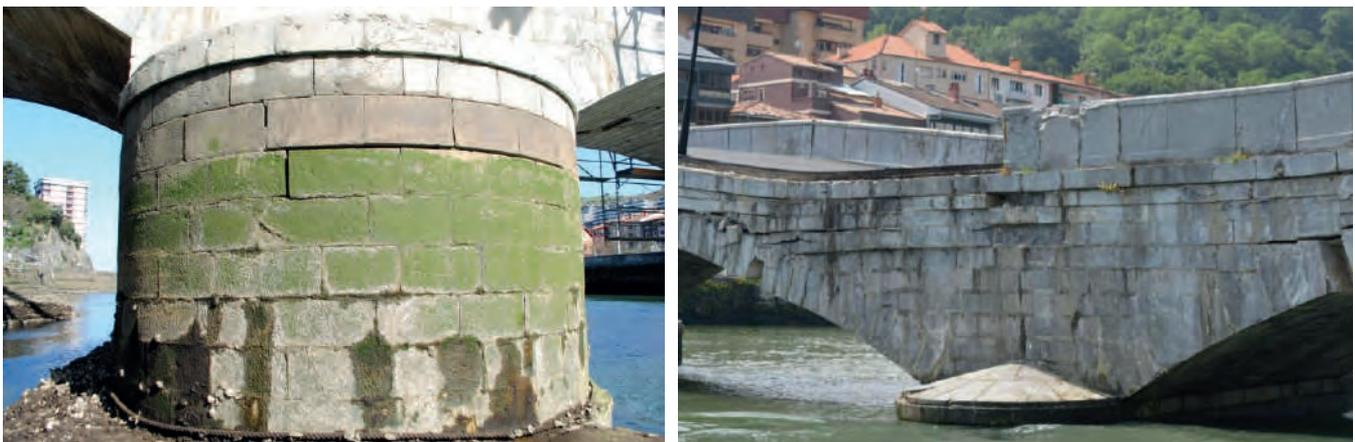
Figura 5. Despegue de sillares en tajamar de aguas arriba de P-3 y piezas rotas a compresión en tímpano sobre pila 2
