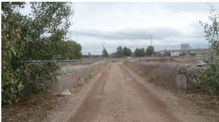
Figura 16. Puente del P. Pontones sobre el río Zapardiel, en S. Vicente, cerca de Gozernarro (Valladolid). Se aprecian el pavimento (zahorra compactada) y los guardarruedas. Foto de los autores
