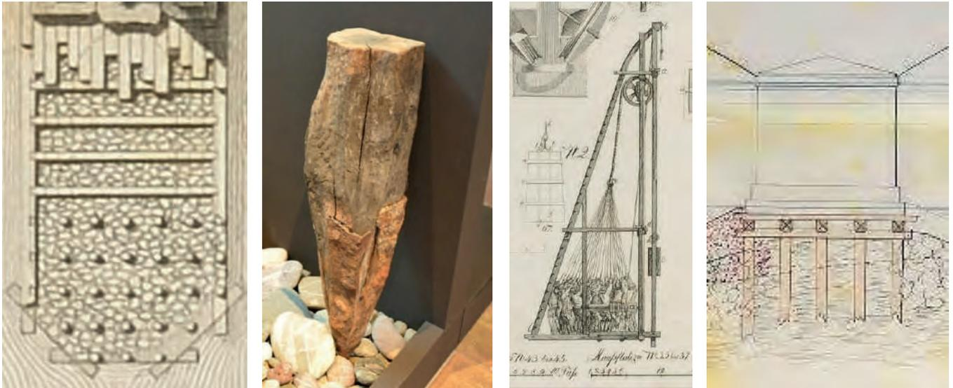
Figura 2. De izquierda a derecha, esquema típico de las cimentaciones con pilotes y encepado de madera (tomado de Wiebeking y Perronet, Biblioteca de la ETSICCP-UPM). Extremo inferior de pilote con azúchre (Museum für Geschichte, Basilea, Suiza). Maquinaria para hincado de pilotes (tomado de Perronet y Wiebeking). Detalle de emparrillado, tarima y zampeado tomado del proyecto de refuerzo del puente de Deba de 1892
