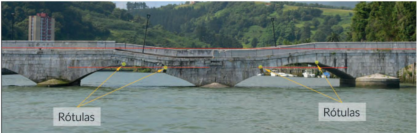
Figura 3. Posición de las rótulas en las bóvedas 2 (izquierda) y 3 (derecha) desde aguas abajo. Se han trazado las líneas presuntamente horizontales de la imposta (roja superior) y las paralelas a ésta por la rótula más baja
