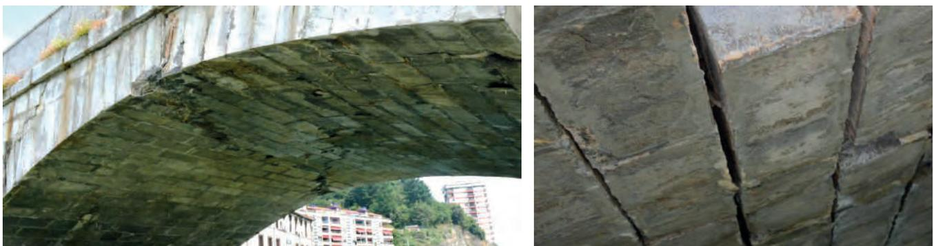
Figura 4. Izquierda, rotura en compresión de intradós de B-3. Derecha, apertura de juntas en intradós de B-2
