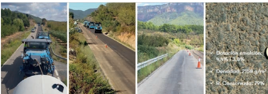
Figura 6. Reportaje fotográfico tramo de reciclado en frío con emulsión innovadora
