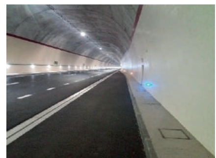
Ilustración 8. Detalle del cierre del apartadero. Túnel de Caldearenas
