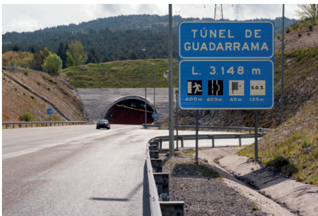
Ilustración 3. Cartel Autopista Tipo 1A
