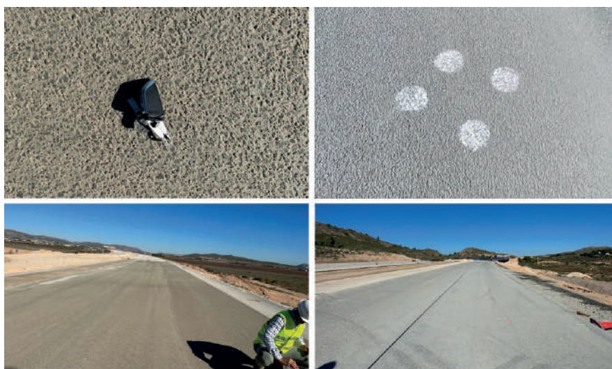
Figura 24. Pruebas de textura realizadas en la zona de hormigón magro
