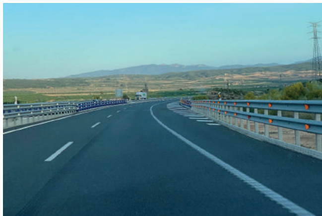
Figura 5. Apartadero exterior sobre sobreecho de estructura de paso inferior
