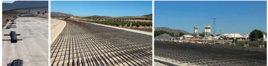
Figura 16. Armado del pavimento
