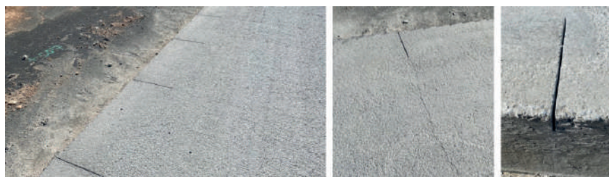
Figura 26. Cortes para inducción del patrón de fisuración
