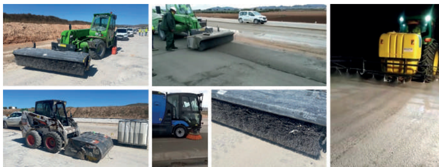
Figura 23. Operaciones de barrido, limpieza y curado final
