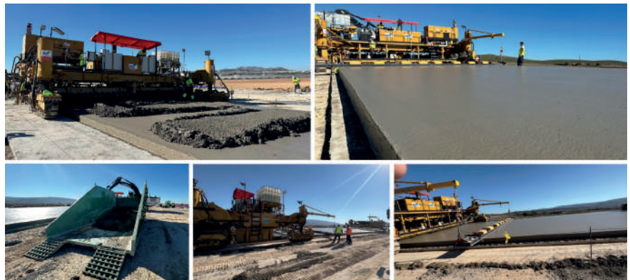
Figura 19: Imágenes del extendido de la capa superior del pavimento bicapa (fotos tomadas el 7 de noviembre de 2022)
