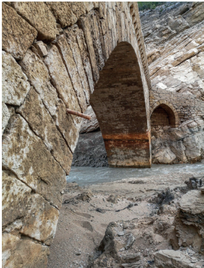
Puente de Castellote, sumergido durante muchos años bajo el pantano de Santolea, una vez iniciados los trabajos de desmontaje en el año 2018.
