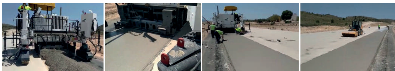
Figura 14. Extendidora WIRTGEN completando el ancho de la capa de hormigón magro
