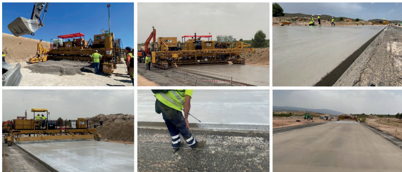
Figura 13. Imágenes del extendido del hormigón magro y curado (fotos tomadas a finales de junio de 2022)
