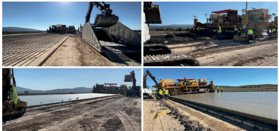
Figura 18: Imágenes del extendido de la capa inferior del pavimento bicapa (fotos tomadas el 7 de noviembre de 2022)
