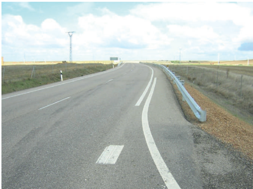
Foto 4. Abatimiento con pieza tope sin enterrar
