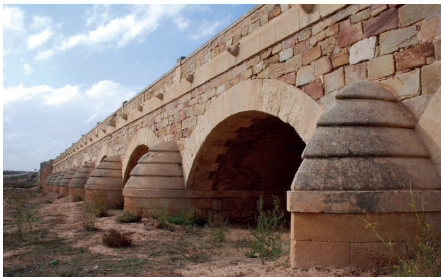
Puente de la Venta de la Vega, en la A-31 a su paso por Almansa.
