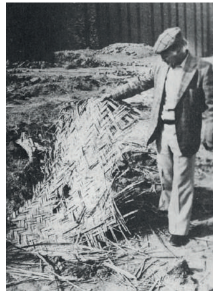
Figura.1 Refuerzo de suelo en el Ziggurat Aqar Quf 1400 a.C (Ziegler, 2017)
