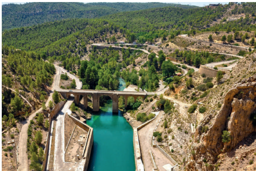
Puente sobre el Río Cabriel, en el puerto de Contreras (Antigua N-III)
