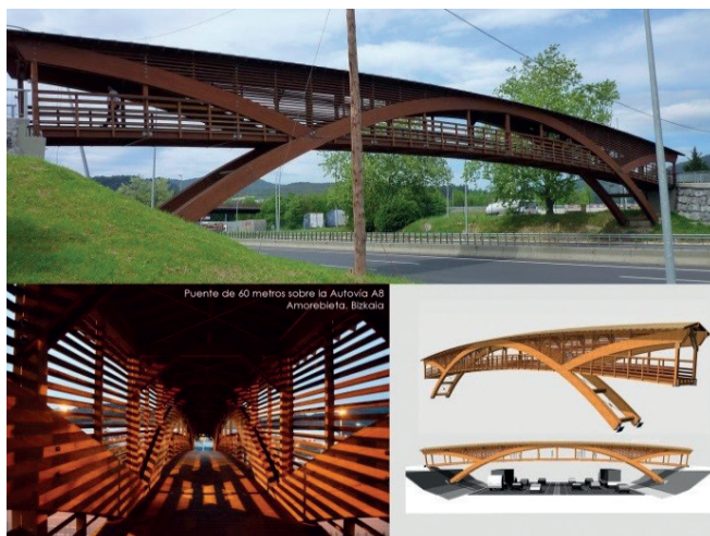
Puente en Amorebieta sobre la A-8 . LUZ de 60M.
