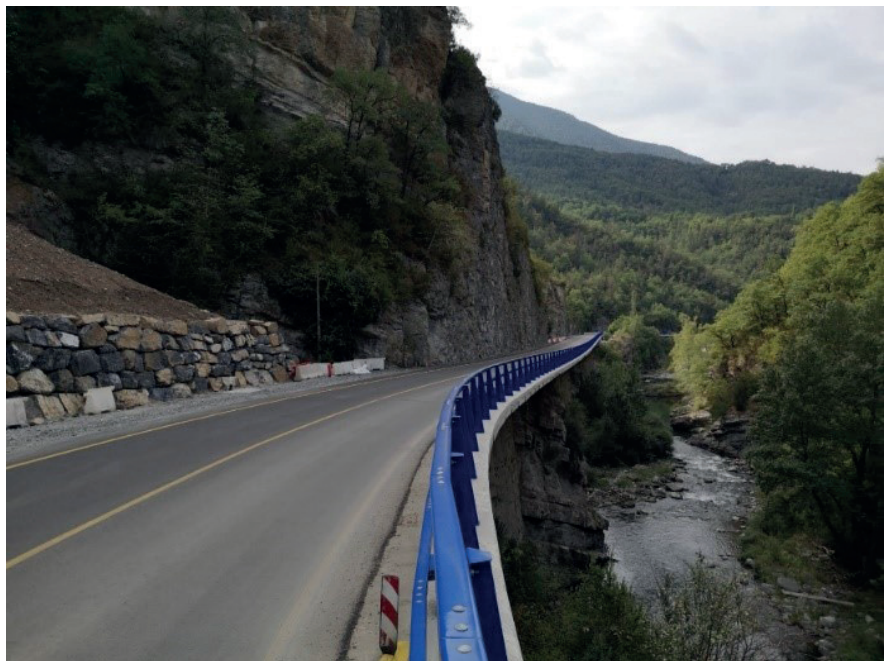
Figura 23. Tramo actual ya prácticamente acondicionado.
