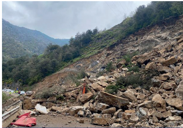
Figura 16. Imagen del deslizamiento y sus consecuencias
