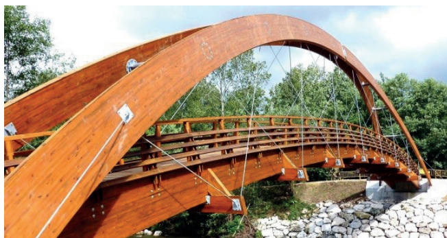
Puente en Cabezón de la Sal. LUZ de 60M.
