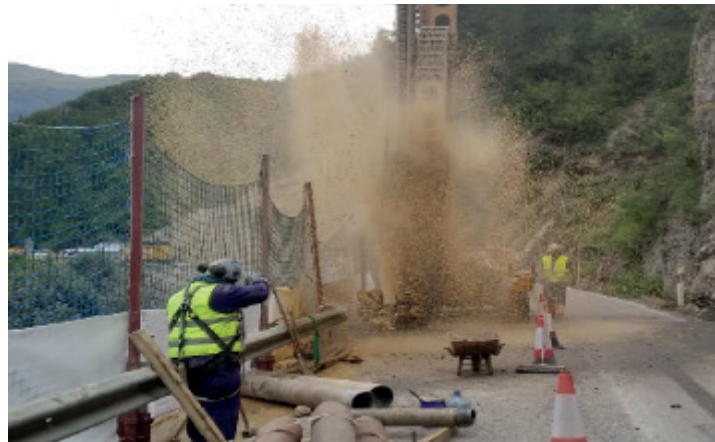
Figura 9. Perforación de micropilotes. Durante el proceso se producen salpicaduras que afectan al tráfico
