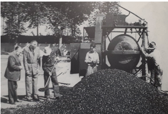
Figura 8. Fabricación de aglomerado en frío con hormigonera en el año 1951.
