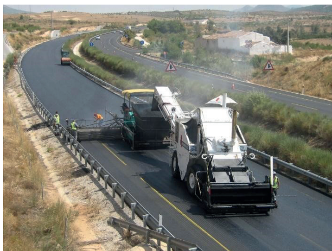
Figura 15: Extendido a ancho completo con empleo de silo de transferencia
