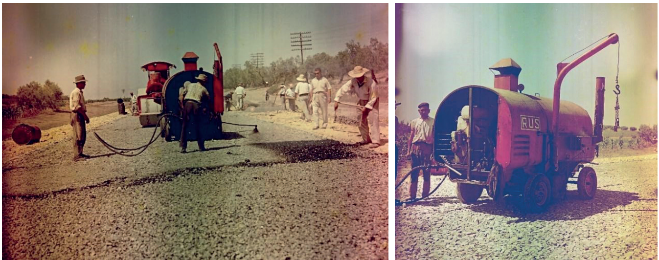
Figura 10. Bituminadoras para la ejecución del riego asfáltico sobre bases granulares 6
