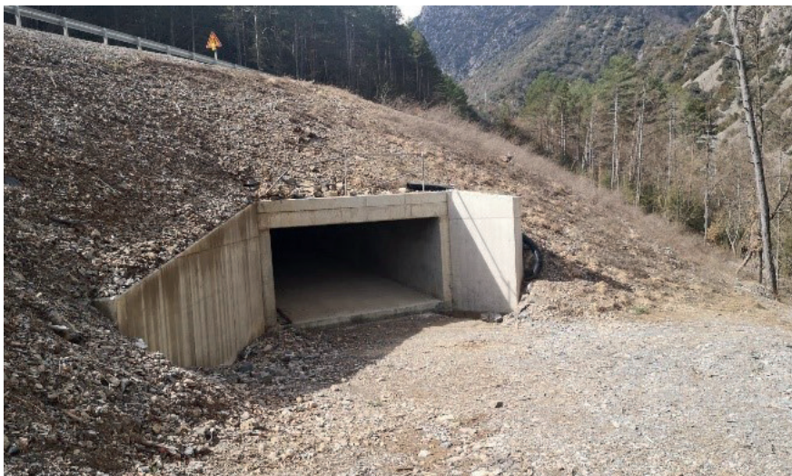
Figura 14. Paso de fauna
