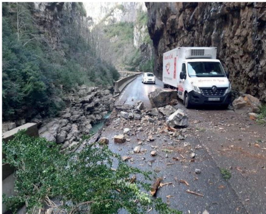
Figura 19. Caída de un bloque de roca sobre la carretera
