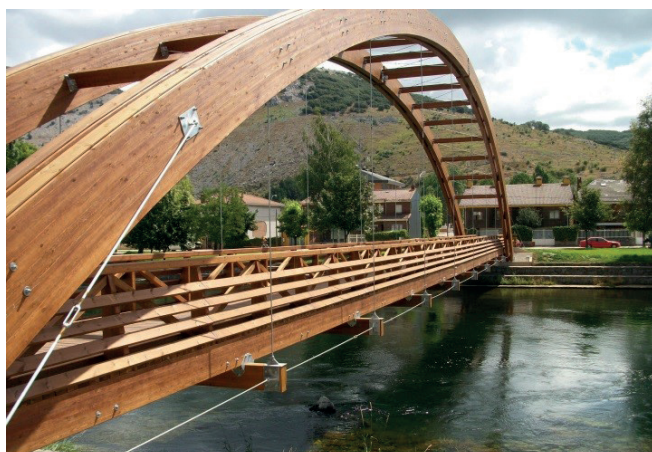
Puente en Velilla del Río Carrión. LUZ de 65M.
