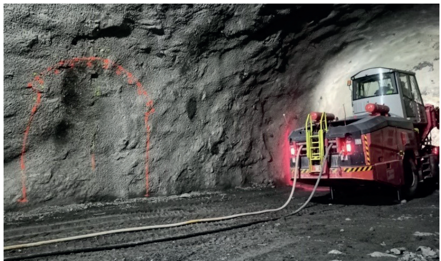
Figura 13. Replanteo de la galería de evacuación
