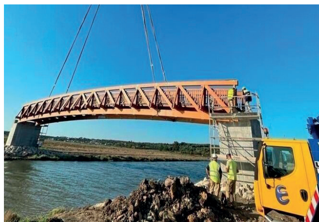
Puentes en Barbate 36 metros-
