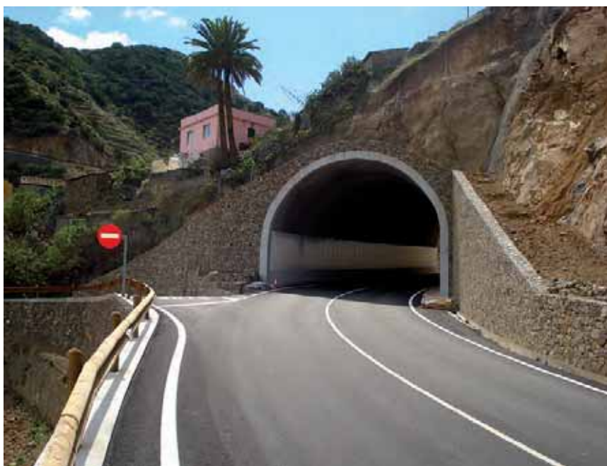
Túnel La Quilla
