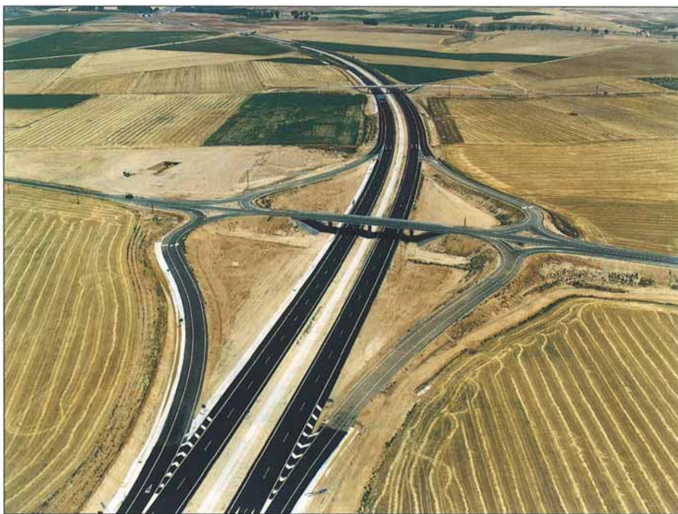
Salvo la estructura ejecutada sobre el ferrocarril, todas las estructuras son losas de hormigón postensado.
