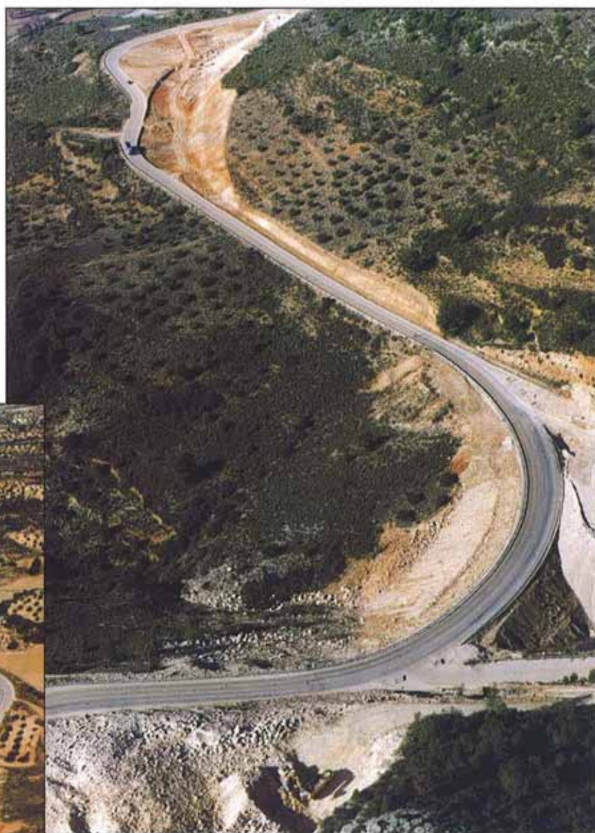
Se han construido 5 enlaces y 12 estructuras.
