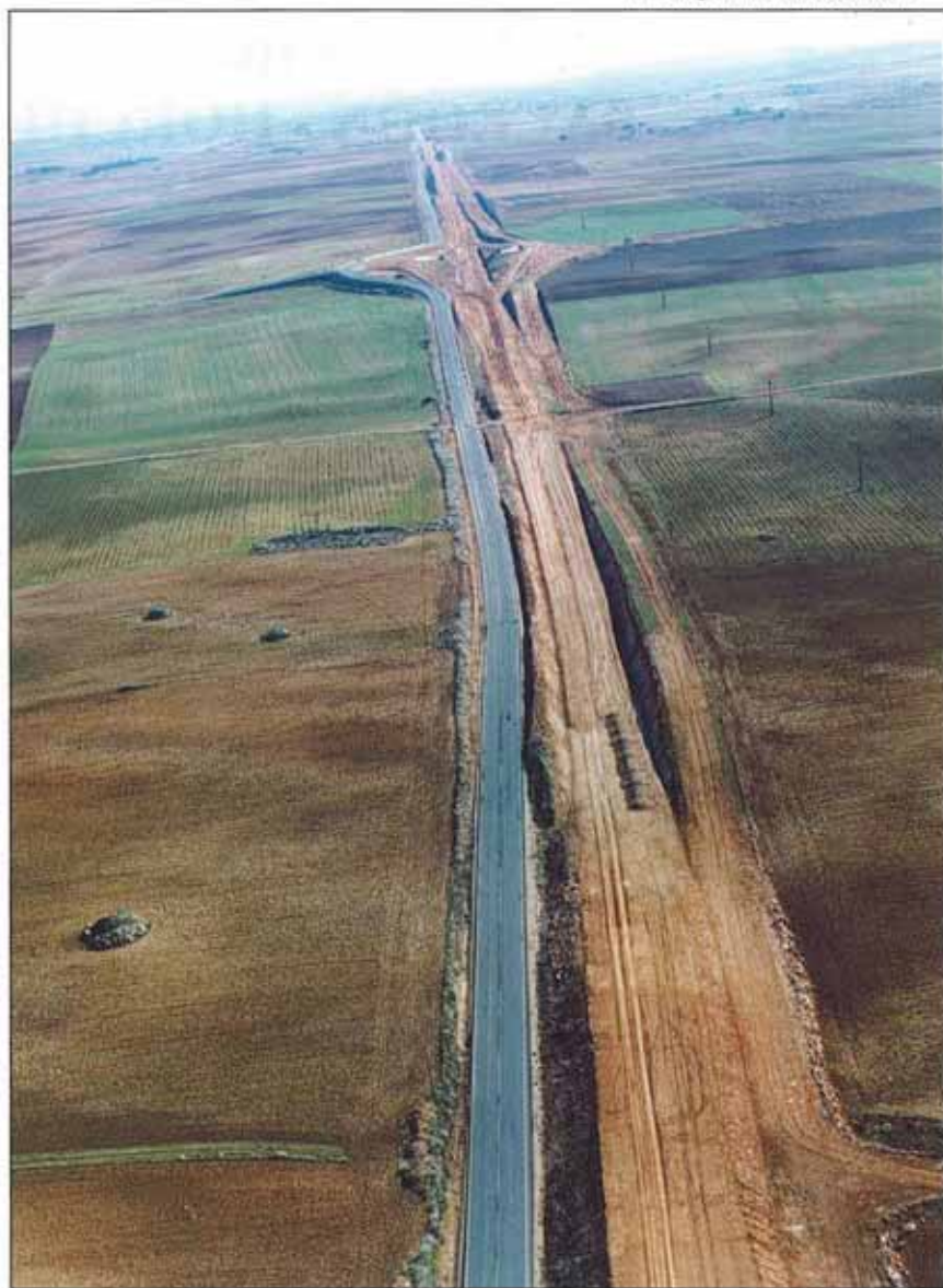
El tramo acondicionado tiene una longitud de 19 km y forma parte del proyecto de conversión de la N-320 en vía rápida.
