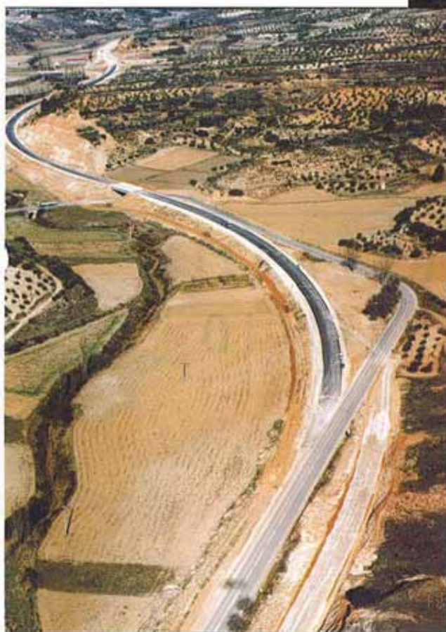
La foto muestra el acondicionamiento realizado.
