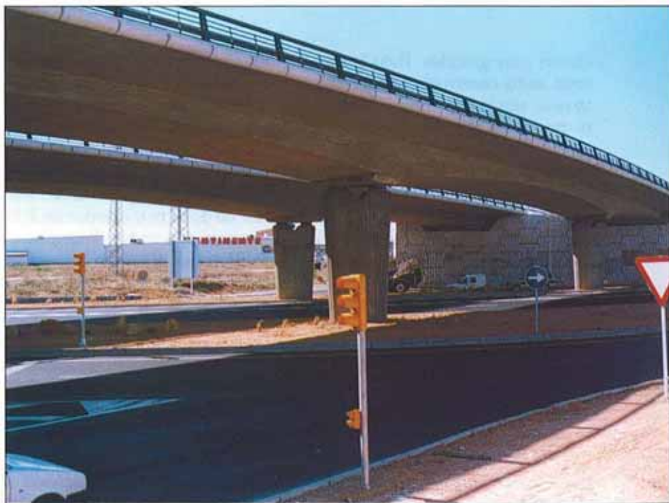
El tramo ha supuesto una inversión de 4 373 Mpta y ha sido cofinanciado con los fondos FEDER.
