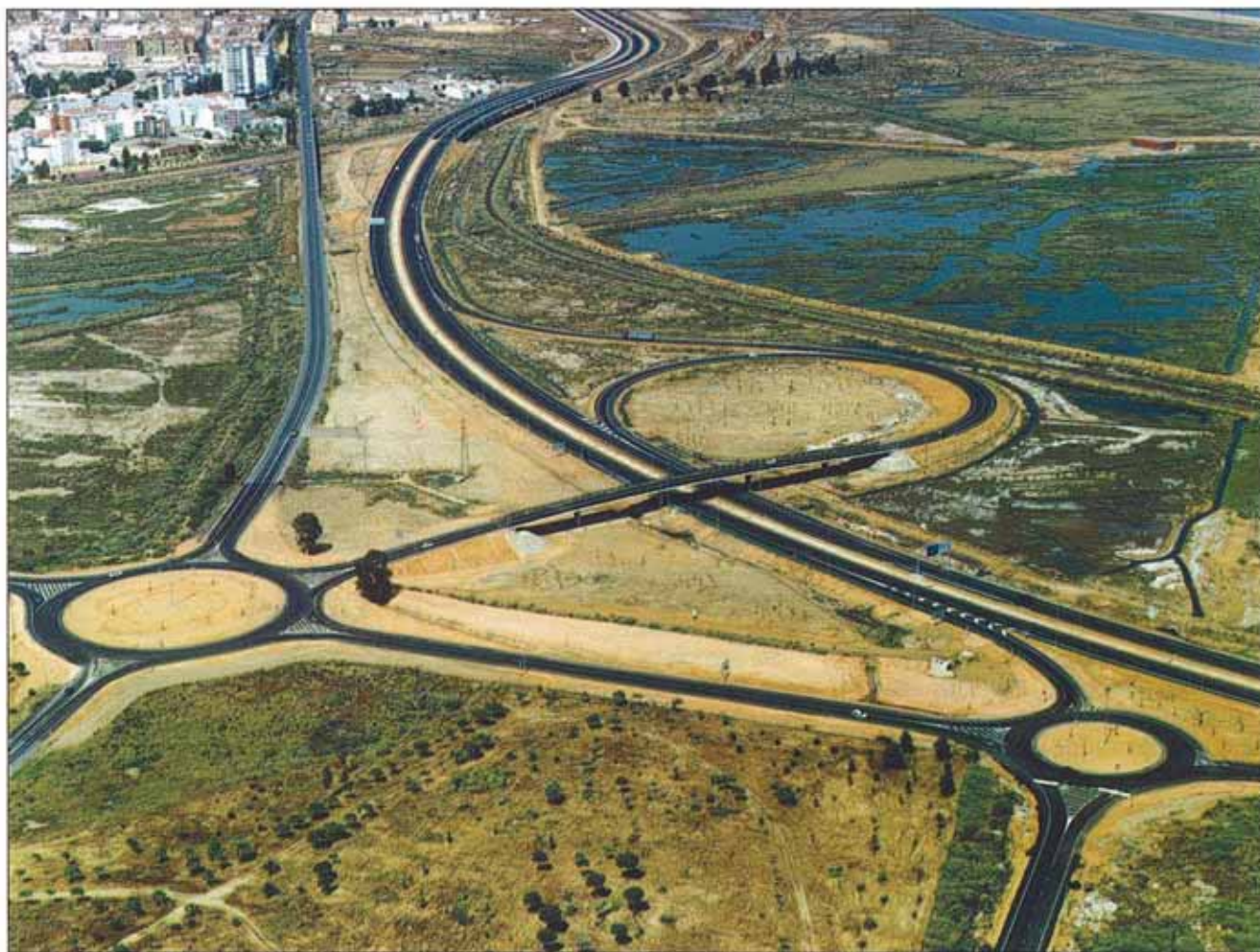
A lo largo de la obra se han construido 2 enlaces (Norte y Sur), un viaducto sobre el ferrocarril y el acceso al polígono industrial.
