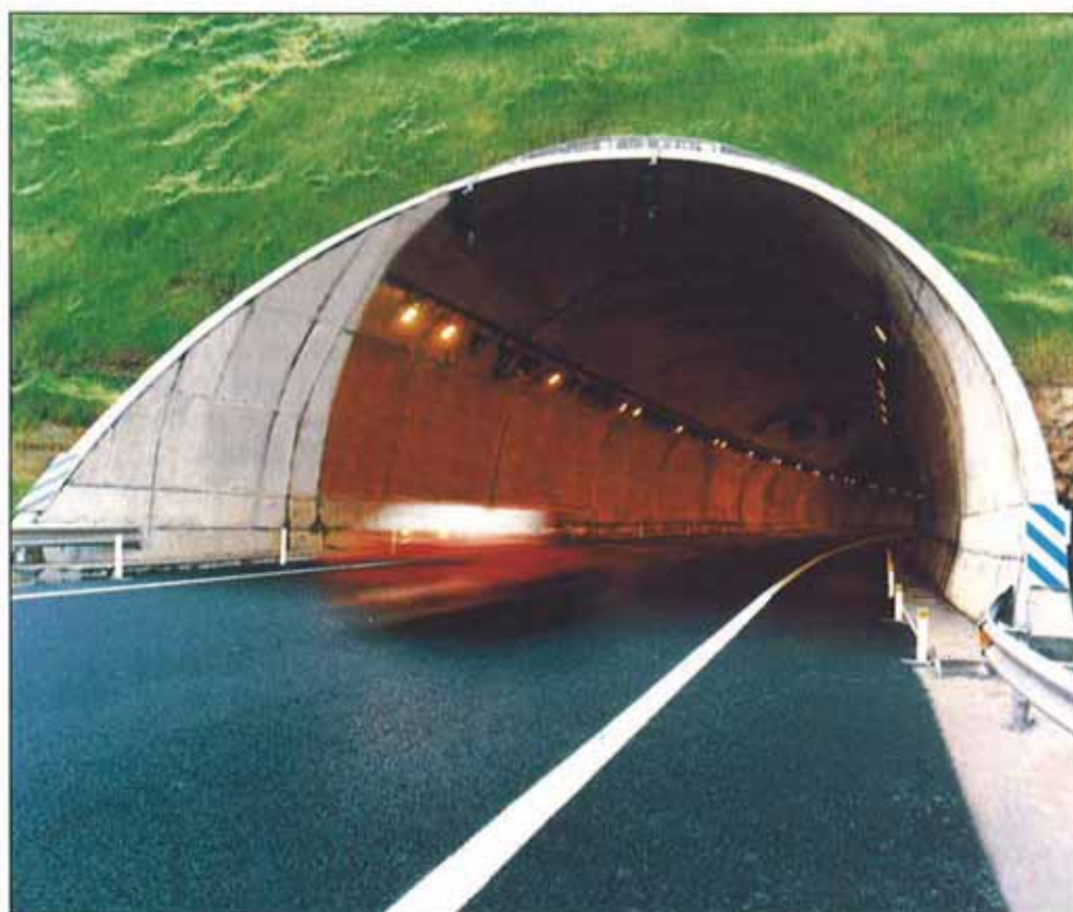
En el tramo Miño-Fene se han construido los túneles de Pedra do Couto y de Campolongo.
