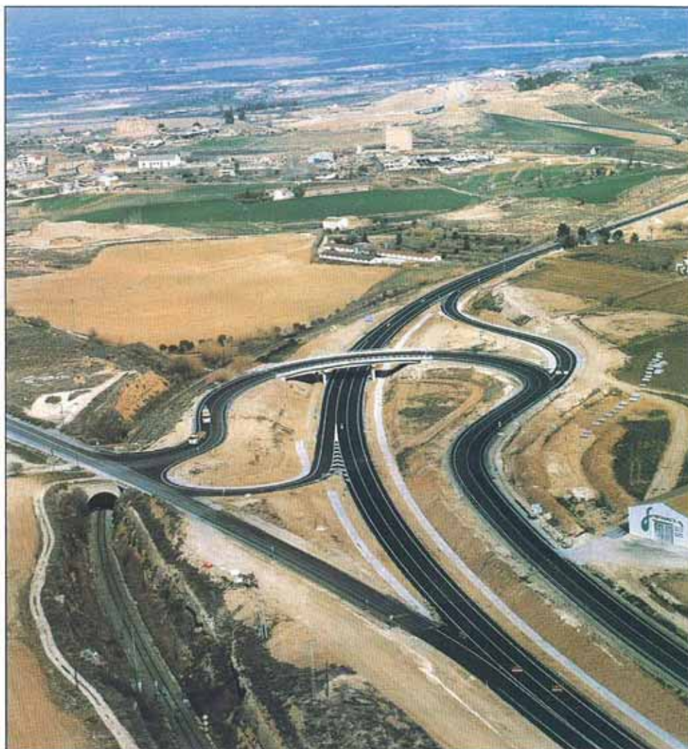
El nuevo tramo tiene 5,1 km de longitud.
