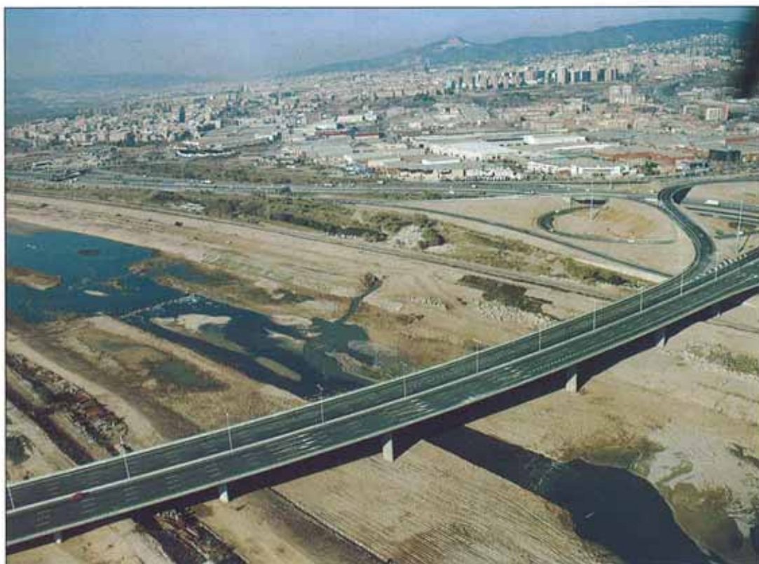
Viaducto sobre el río Llobregat.
