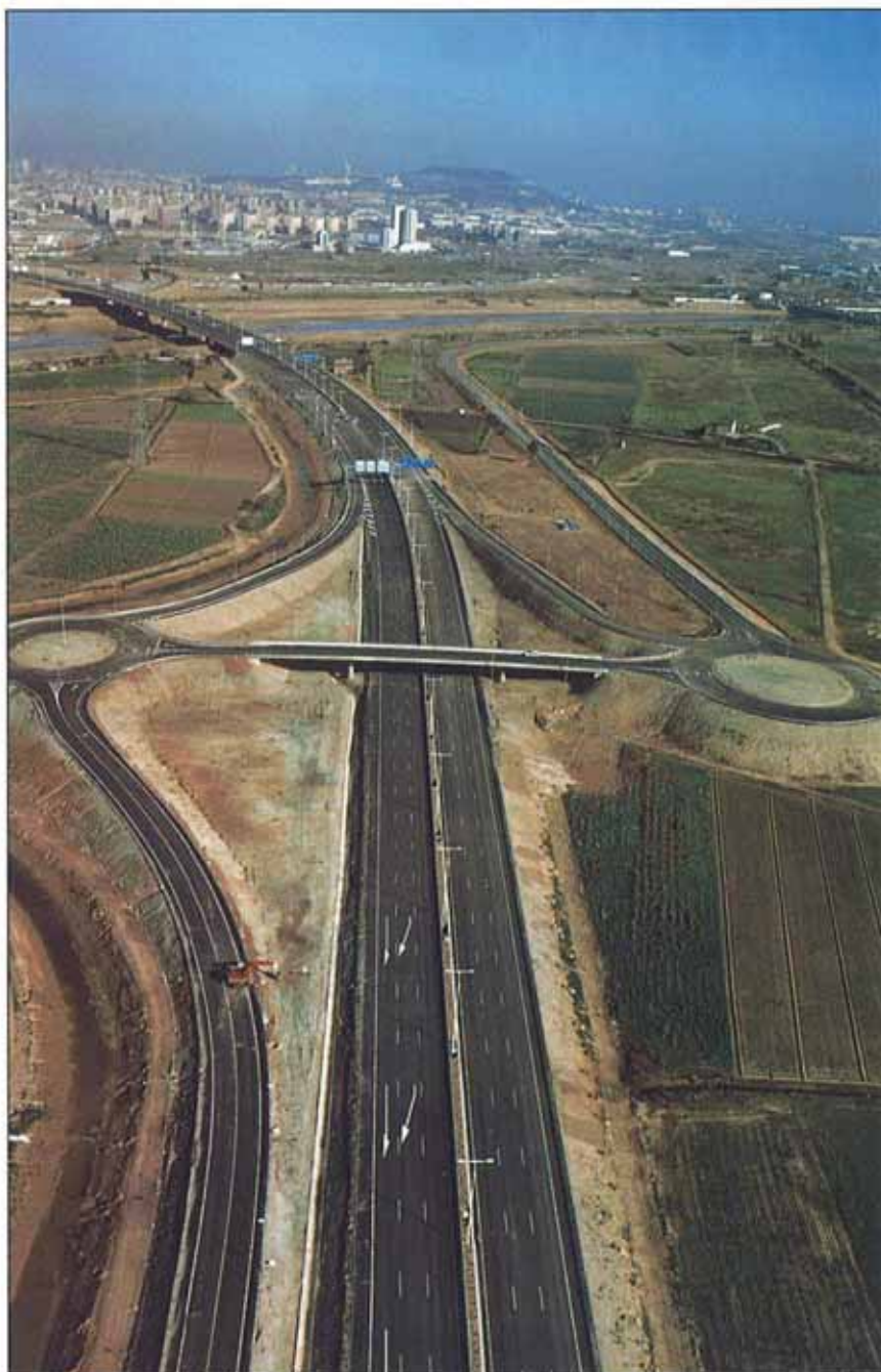
El tramo tiene una longitud de 7 km con otros 35 km de ramales y vías de servicio.
