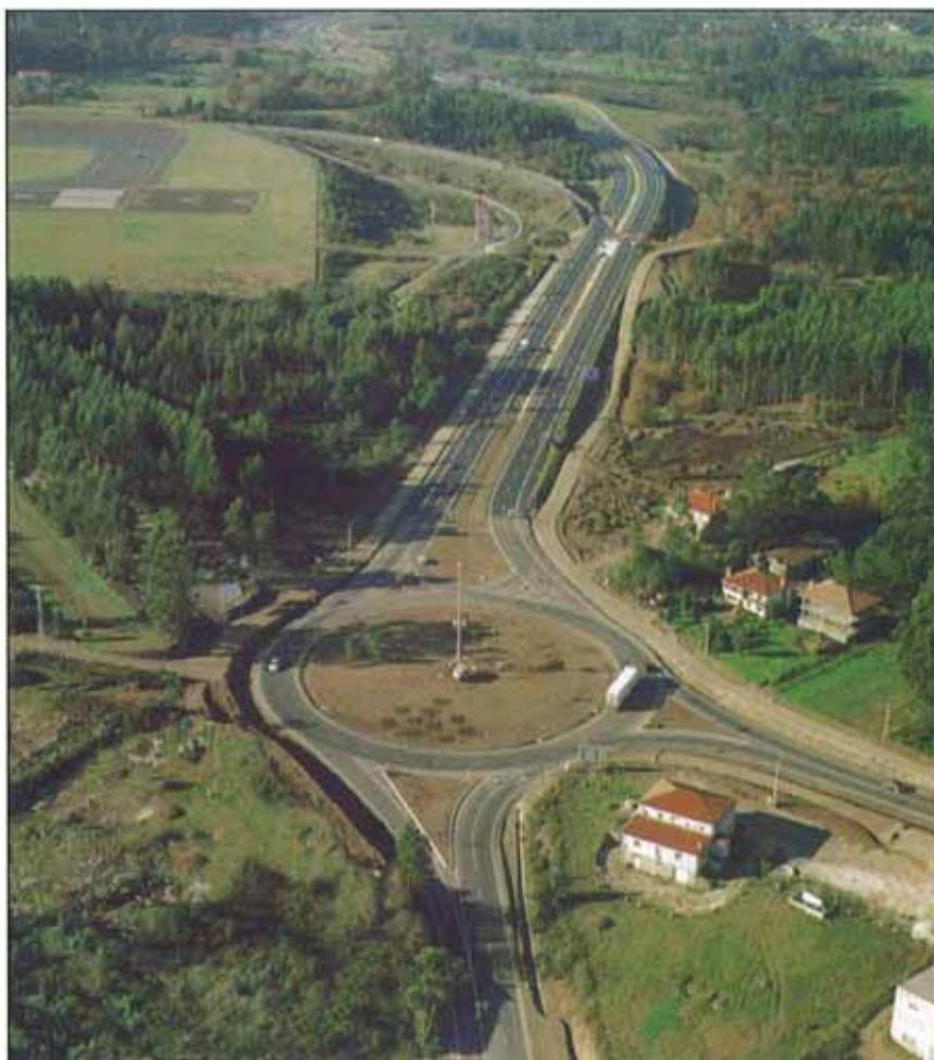
El tramo tiene una longitud de 10 260 m y dos glorietas: una al principio y otra al final del tramo.
