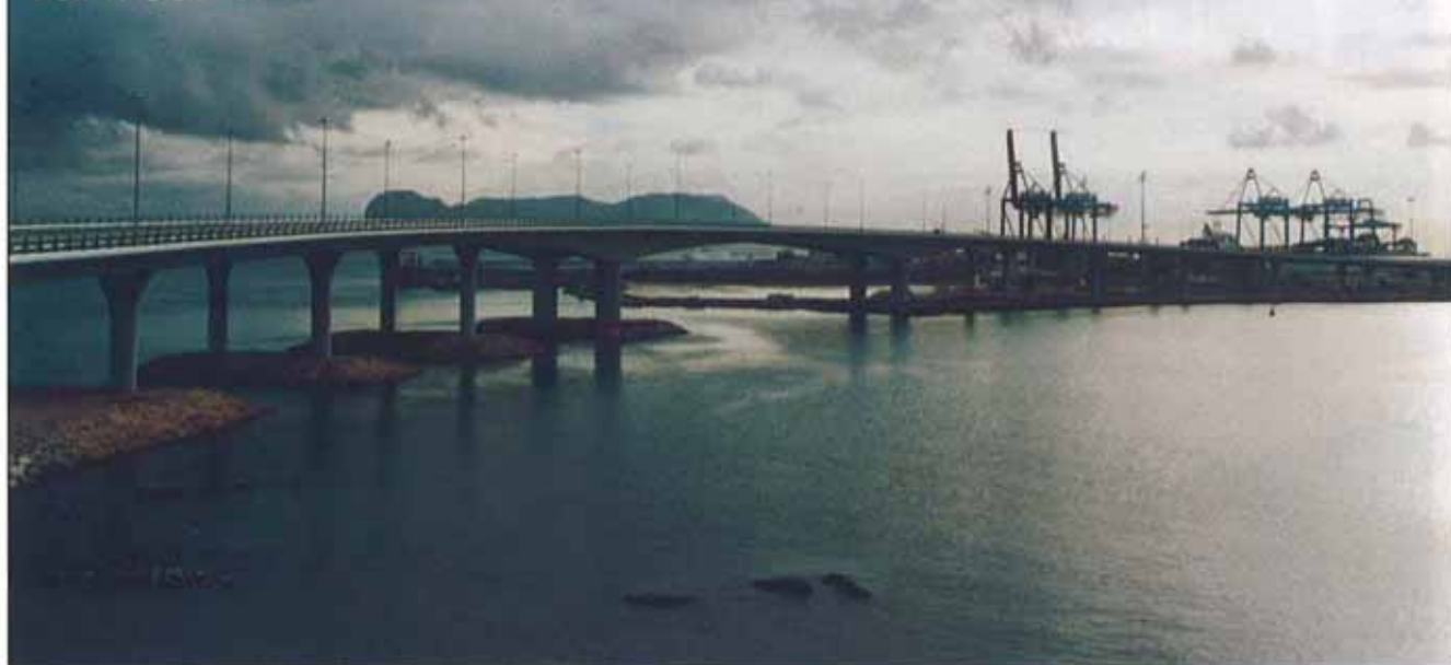
Vista panorámica de la obra.
