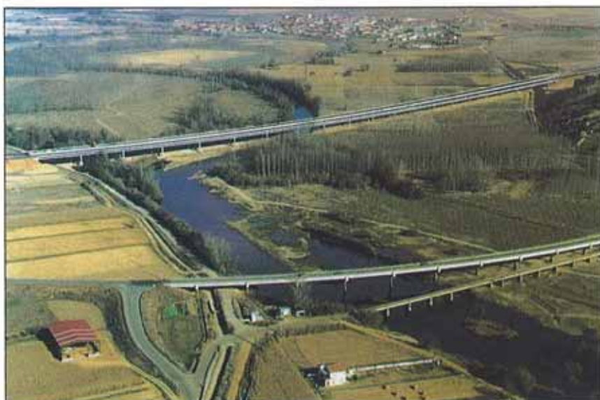
Se han ejecutado dos viaductos sobre el río Órbigo y el arroyo de la Almucera.
