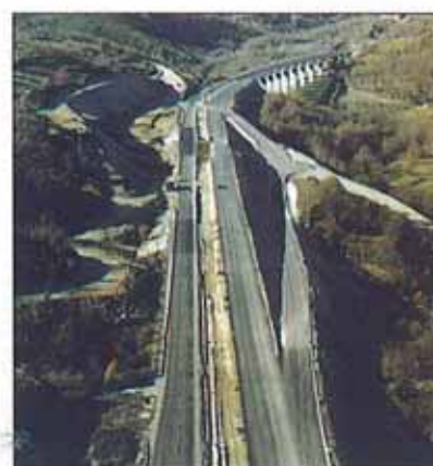
Viaducto de Tuela y enlace de Lubián.
