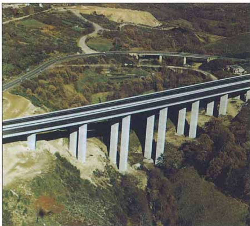
Viaducto de Villavieja.
