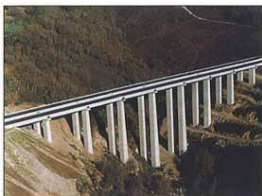
Viaducto de Vilariño, de 380 m de longitud.
