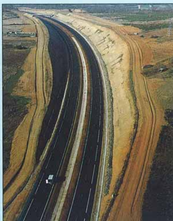
El tramo tiene una longitud de 23,7 km. En la foto, enlace de Albares.
