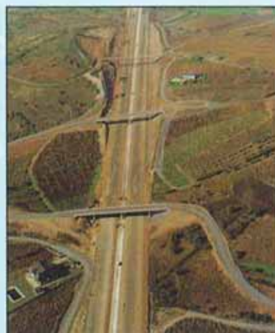
Vista parcial del tramo con pasos elevados en la fase de construcción.
