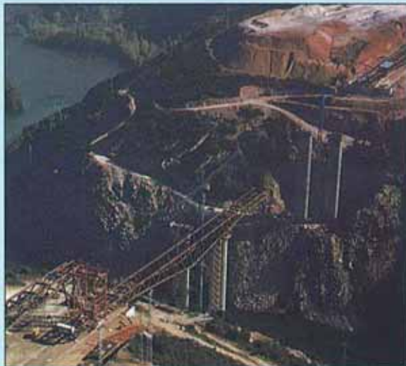
Vista general del viaducto sobre el Río Sil.
