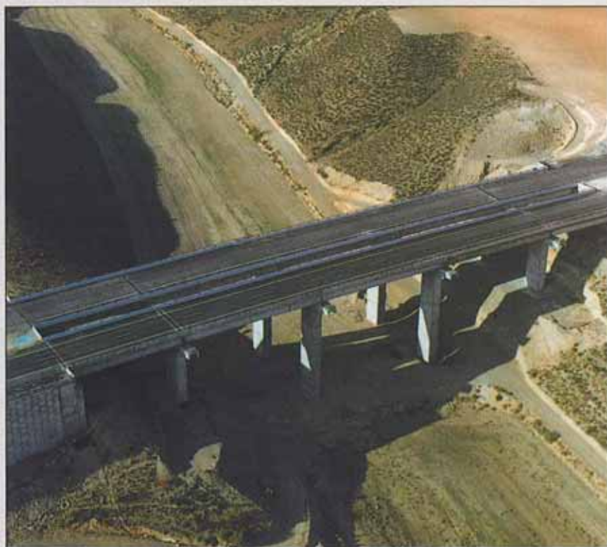
Se han construido como estructuras singulares el tramo del viaducto del val de los Olivares y el puente sobre el río Gállego.
