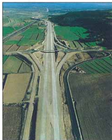
Vista parcial de un tramo de la autovía en la fase de construcción.
