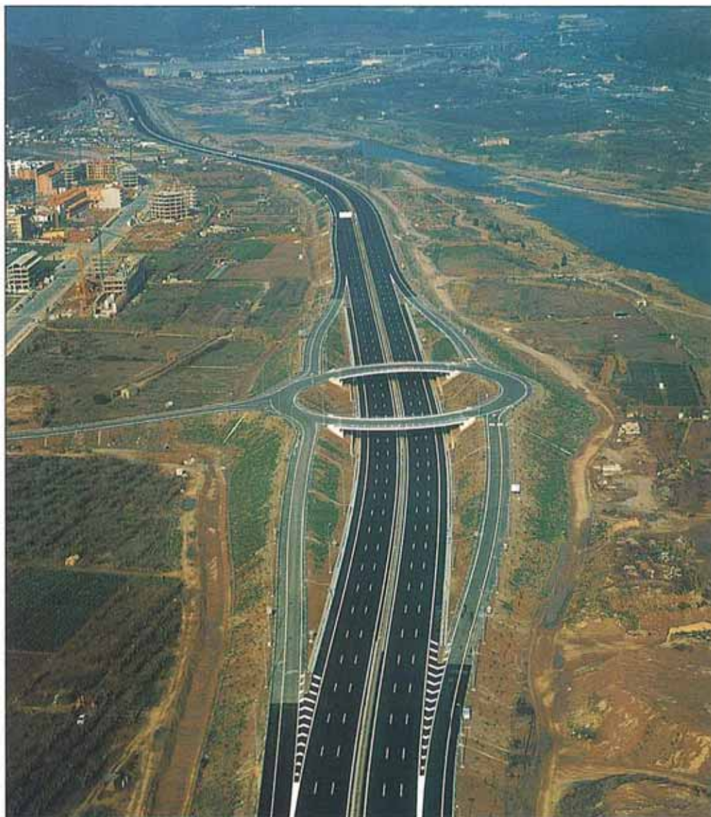
Cinco de los enlaces tienen forma de diamante con glorieta elevada.
