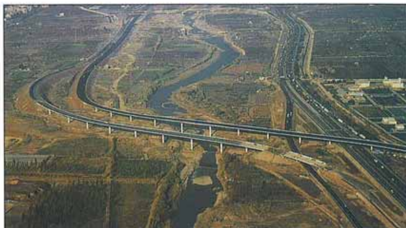
Viaductos del Llobregat.
