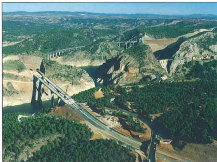
Perspectiva general de la obra.
