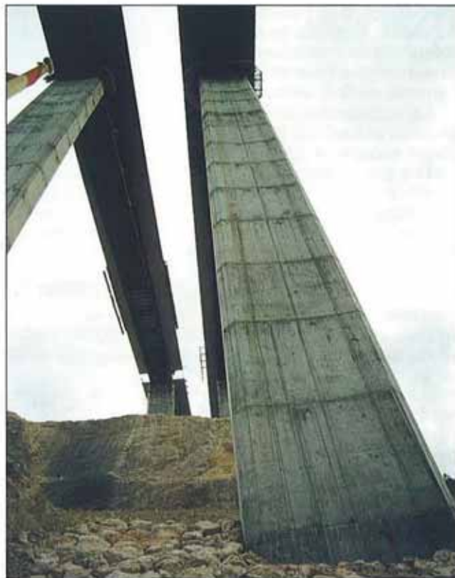
La altura máxima de pilas ha sido de 95 m.
