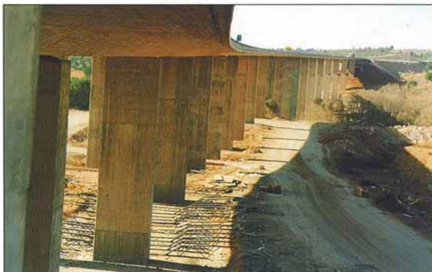
Se han construido seis viaductos en este tramo.
