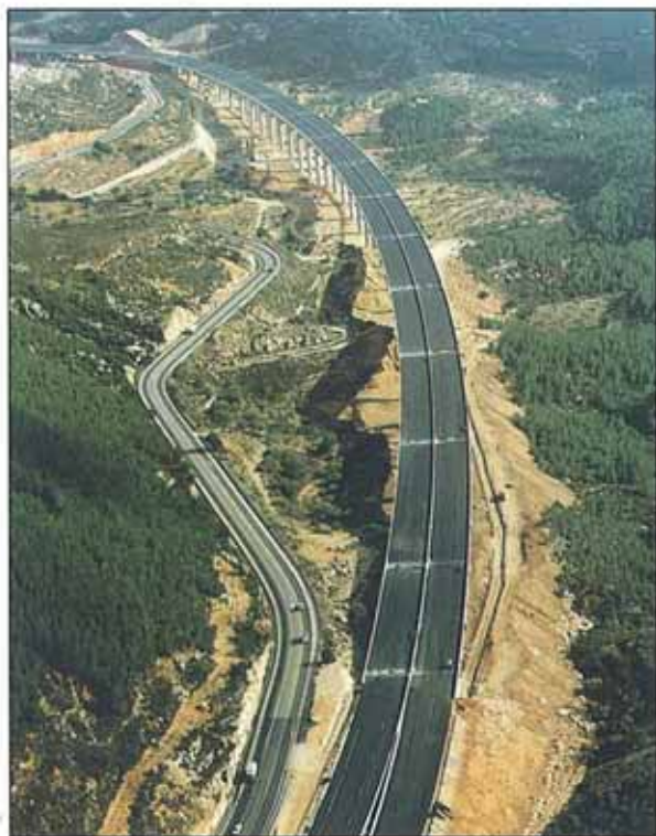
Foto retrospectiva del viaducto de Buñol en los días previos a su inauguración.
