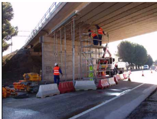
Detalle de la reparación con corte parcial de carril.
