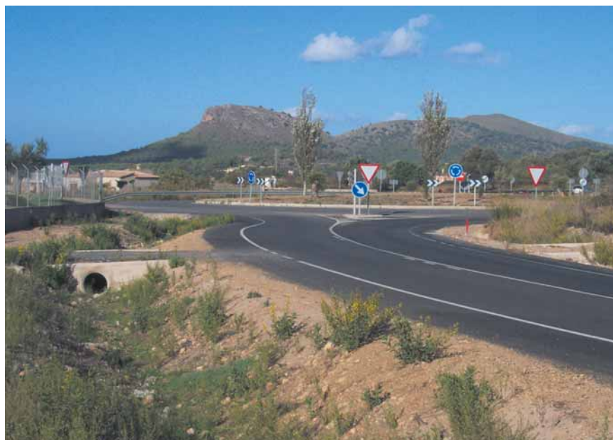
Las inspecciones de seguridad vial de las carreteras en servicio tienen como fin identificar elementos que puedan contribuir a aumentar el riesgo de que se produzcan accidentes para corregirlos a través de actuaciones preventivas.
