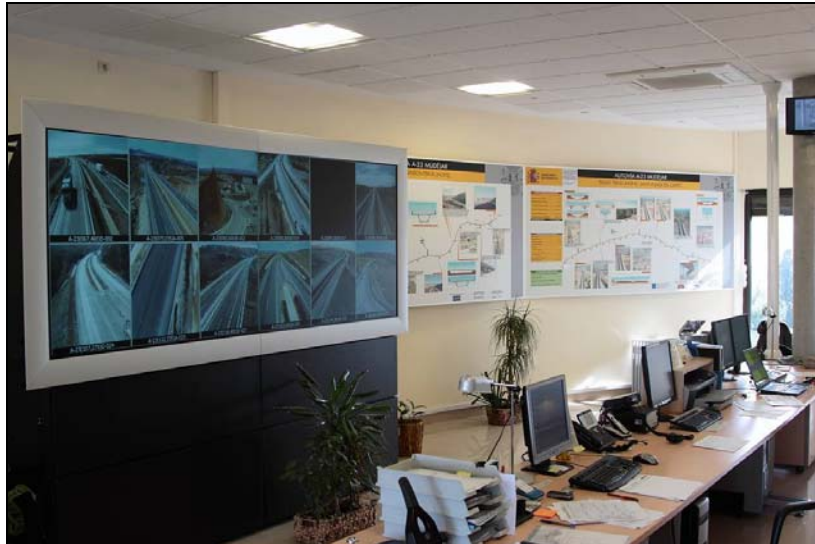
Figura 1.- Centro de Conservación de Carreteras. Año 2003
