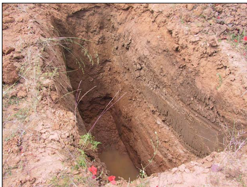
Figura 6.- Detalle de calicata
