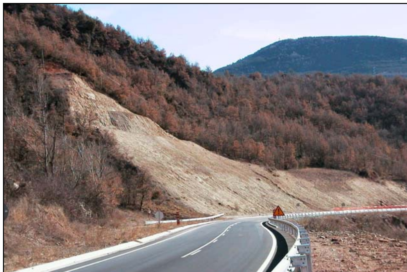
Figura 4.- Detalle de desmonte en la carretera N-260
