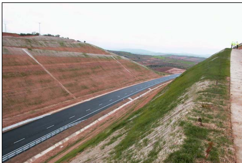
Figura 2.- Estado final del desmonte de la Figura 1 en la carretera N-232
