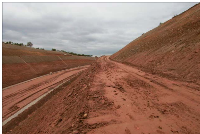
Figura 1.- Estado inicial de obra en desmonte en la carretera N-232
