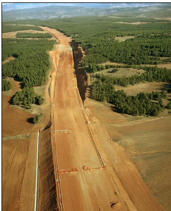
Figura 5.- Sucesión de rellenos y desmontes en la autovía A-23
