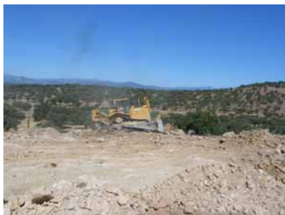
Foto 4: Material de pedraplén
