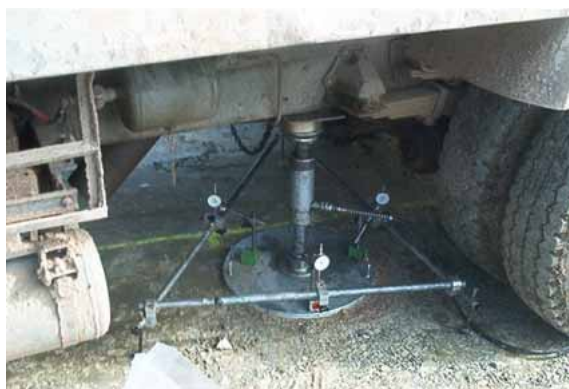
Foto 3: Ensayo de placa de carga
