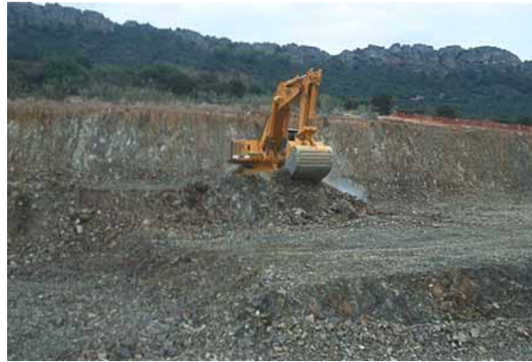
Foto 1: Desmonte en roca para su uso en rellenos
