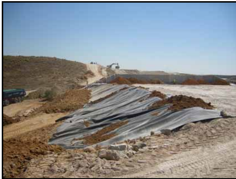
Foto 3.3 - Detalle de la lámina de protección del núcleo
