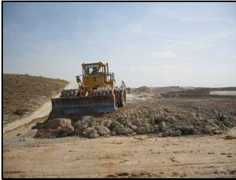
Foto 3.2 - Extendido del material yesífero excavado
