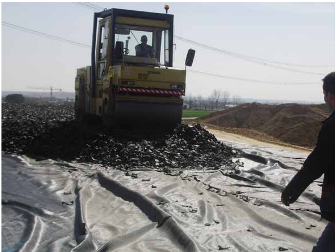
Figura 2 Compactación de las capas de NFU
