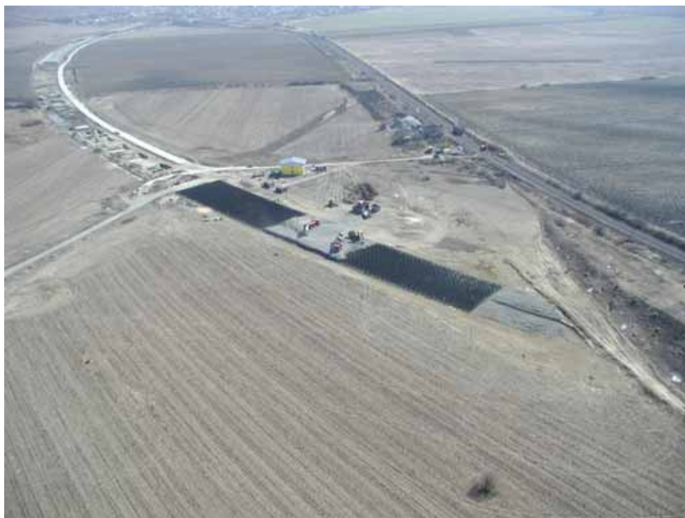
Fig 15: Vista aérea del Colchón de Geoceldas Tensar
