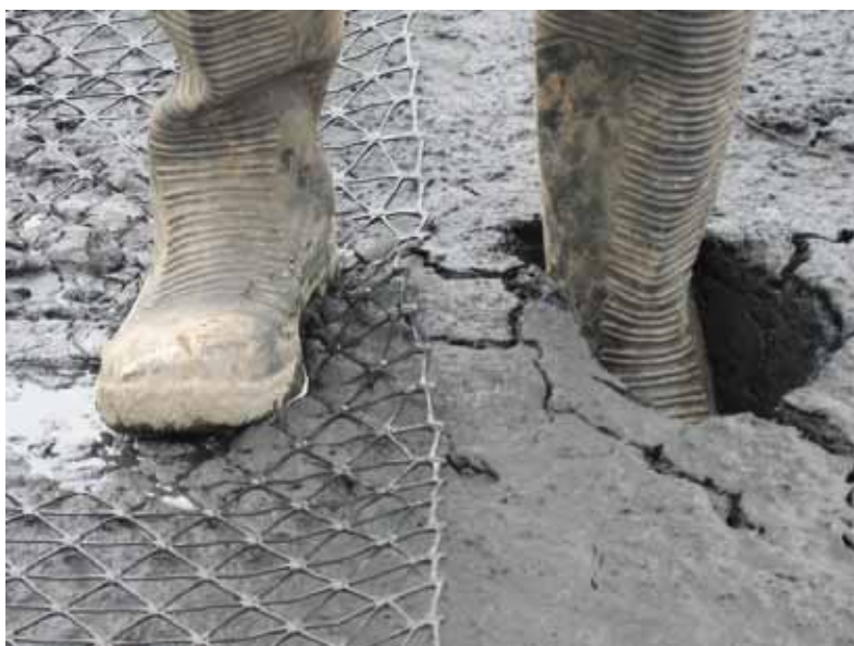
Fig 1: La geomalla TriAx TM proporciona una plataforma de trabajo sobre suelos blandos
