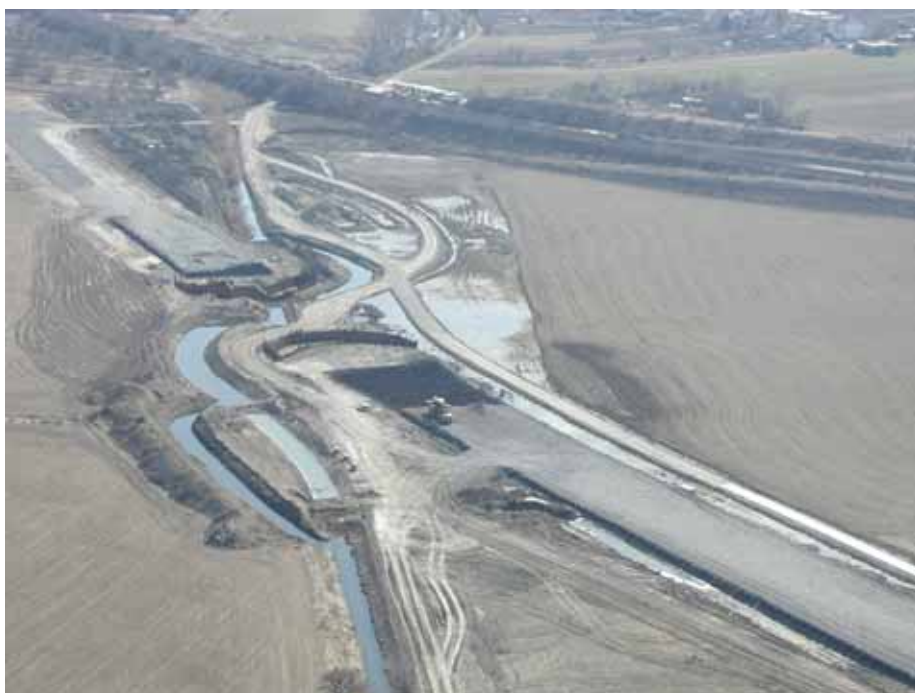
Fig. 14: Vista aérea del cruce con el canal central.
