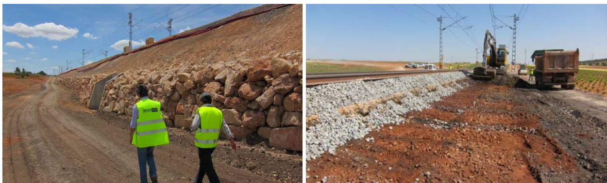
Figura nº 10. Vista de la margen izquierda y de la plataforma durante la intervención.
