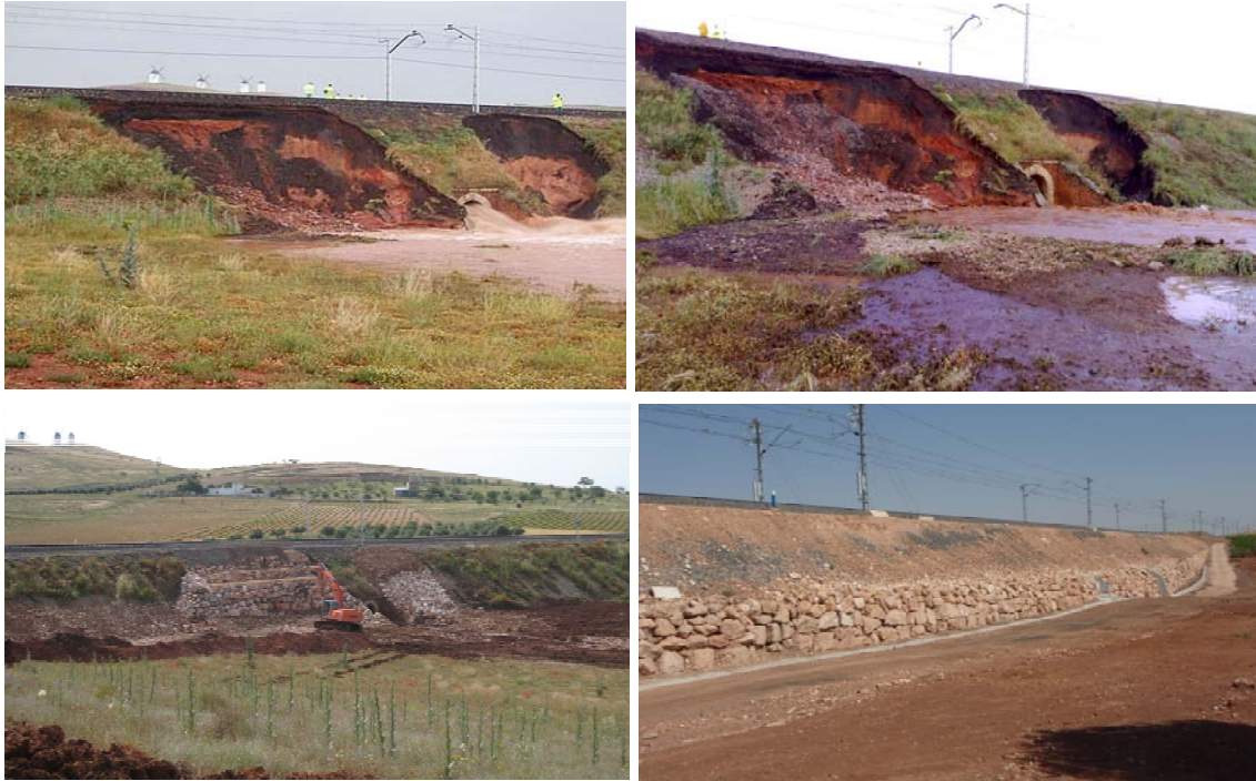
Figura nº 5. Vista de la margen izquierda del terraplén en distintas fases. Primera hora del día 24 de mayo de 2007, última hora del 24 de mayo de 2007, día 27 de mayo de 2007 y junio de 2010, respectivamente.
