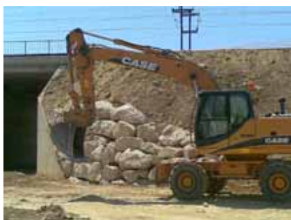
Figura 13: Escolleras dispuestas en las aletas del paso inferior
