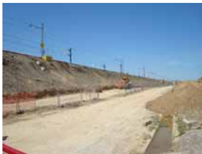
Figura 14: Trabajos previos de desbroce
