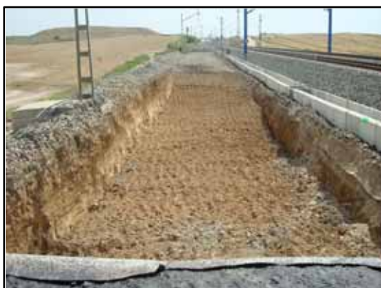
Figura 19: Rebaje de la plataforma en el entorno del paso inferior
