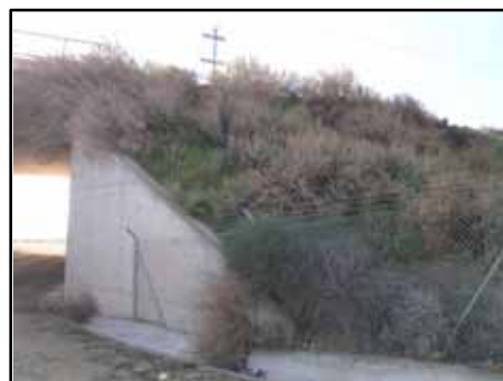
Figura 2: Terraplén existente en la línea convencional y paso inferior antes de las obras
