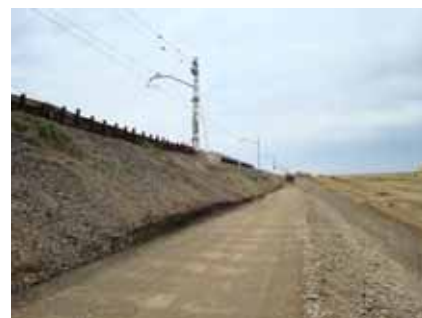
Figura 15: Recreido de terraplén.
