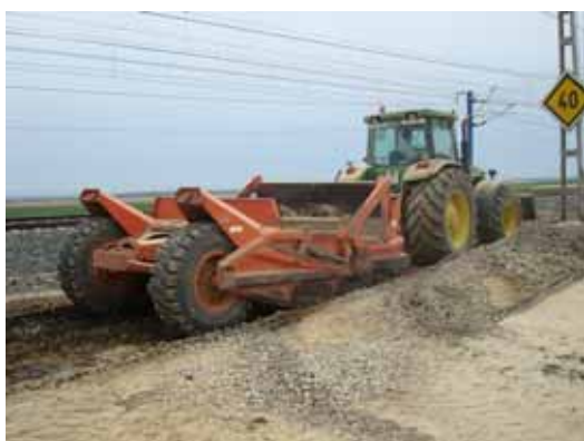
Figura 16: Trabajos de rebaje de la coronación de terraplén
