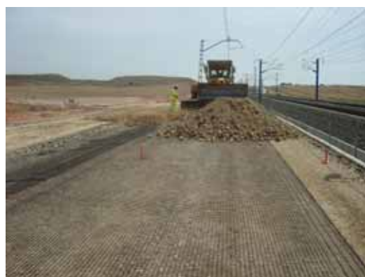
Figura 17: Trabajos de colocación de geomalla y extendido de material
